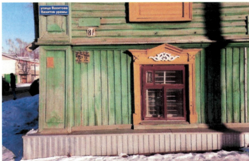
Рис. 14. Фрагмент бокового фасада. Оформление оконного проема, угловой лопатки первого этажа
