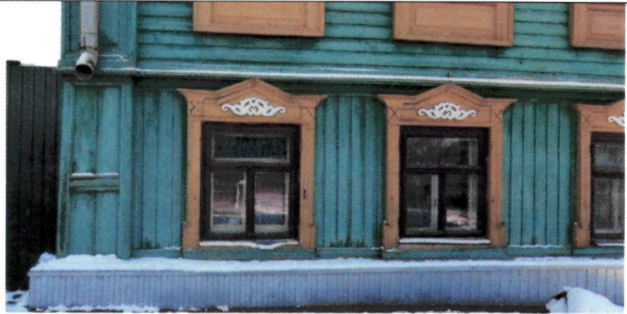
Рис. 10. Оформление оконных проемов первого этажа
