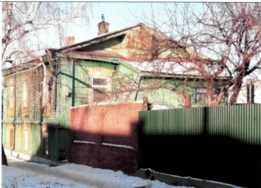
Рис. 15. Южный (торцевой) фасад
