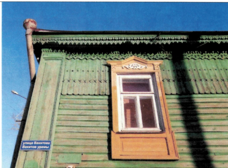
Рис. 13. Фрагмент бокового фасада. Оформление оконного проема, угловой лопатки второго этажа, венчающего карниза и фриза
