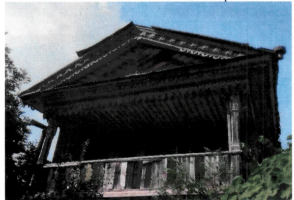
Рис. 28. Балкон юго-восточного фасада
