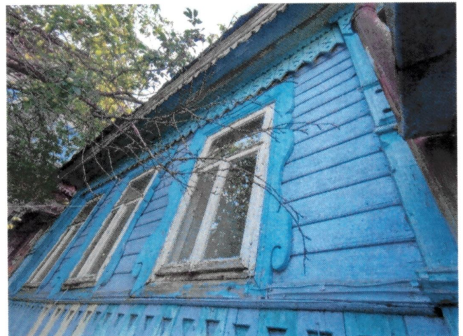
Рис. 21, 22. Наличники оконных проемов
