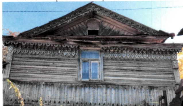
Рис. 19. Фронтон юго-западного фасада
