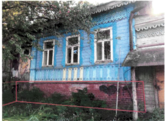
Рис. 31. Открытая кирпичная кладка фундамента
