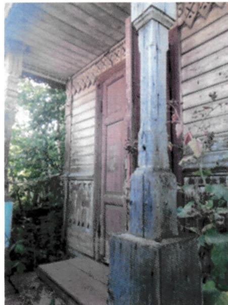
Рис. 13, 14. Фрагменты крыльца северо-восточного фасада
