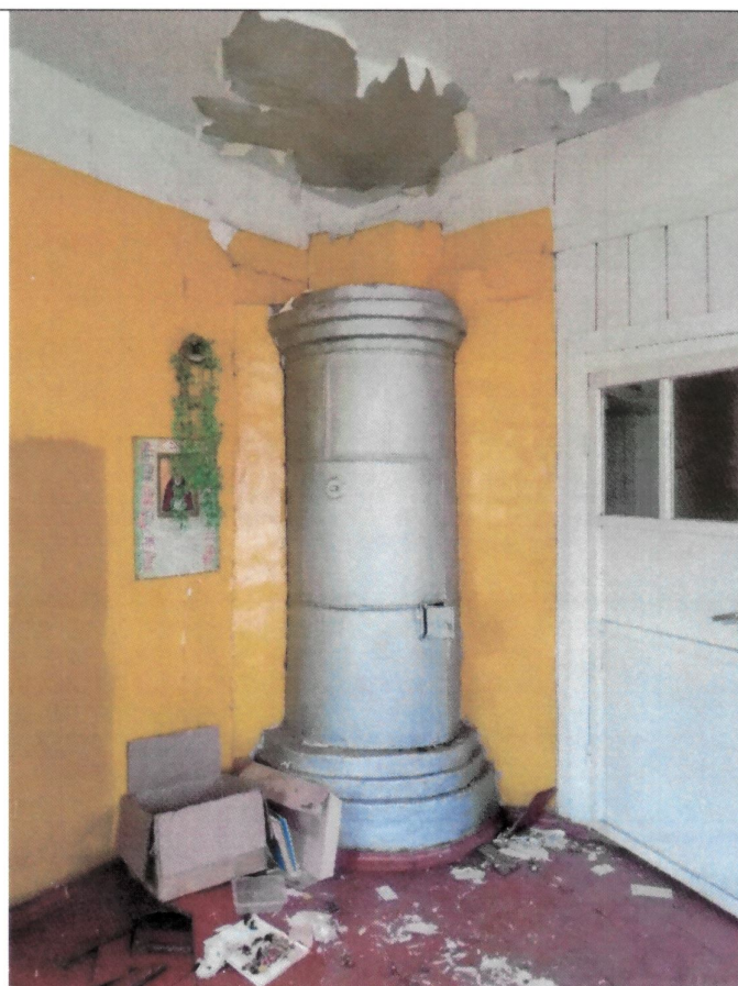
Рис. 43. Круглая в плане металлическая печь
