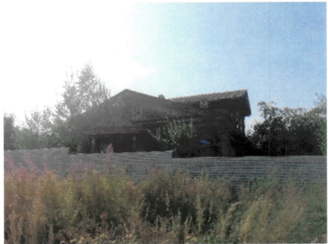
Рис. 11. Общий вид северо-восточного фасада
