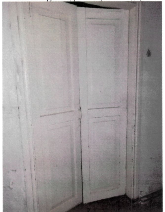
Рис. 33. Внутренняя деревянная филенчатая дверь
