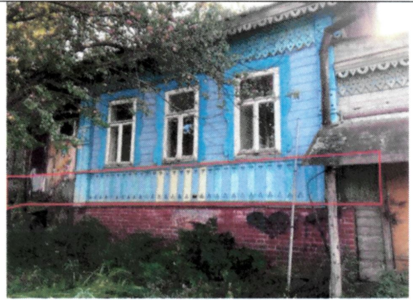
Рис. 26. Обшивка нижнего пояса
