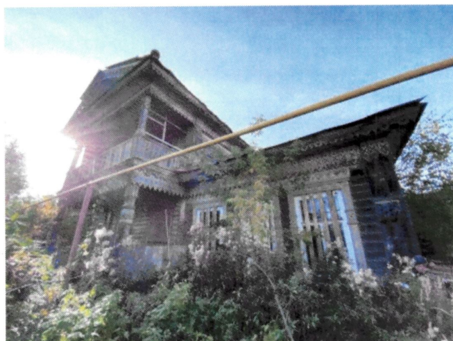
Рис. 6. Общий вид юго-восточного фасада
