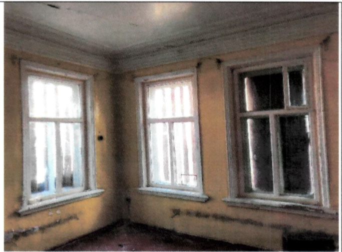
Рис. 34. Профилированные деревянные оконные рамы
