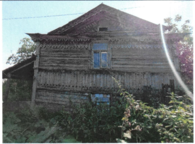
Рис. 10. Вид на северо-западный фасад
