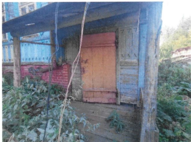
Рис. 7 – 9. Общие виды северо-западного фасада
