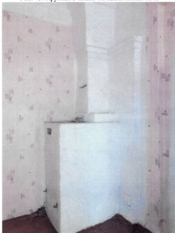
Рис. 44. Угловая прямоугольная в плане кирпичная печь
