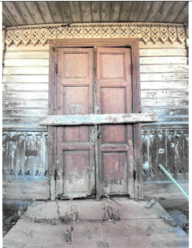
Рис. 32. Наружная деревянная филенчатая дверь
