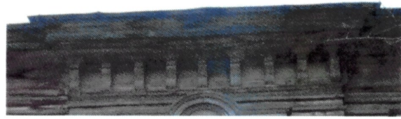
Рис. 5. Деревянный карниз с кронштейнами
