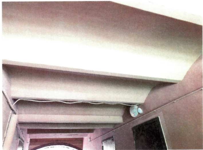
Рис. 5. Сводчатые перекрытия проездной арки
