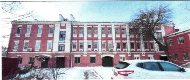
Рис. 7. Главный фасад по ул. Баумана (северный фасад)
