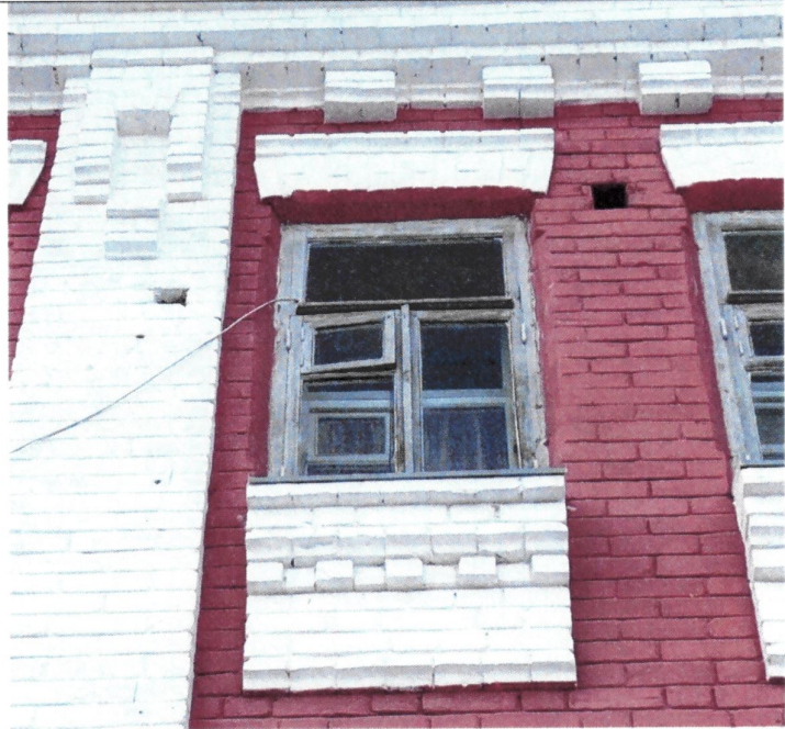
Рис. 4. Кирпичные перемычки оконных проемов
