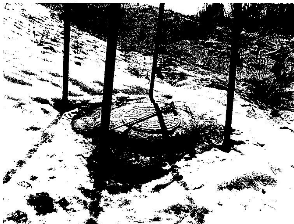
Рис. 8. Люк над каптажной камерой
