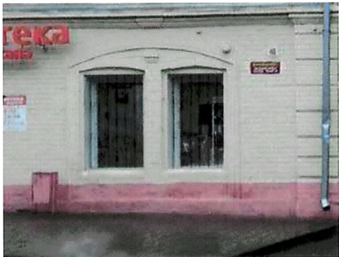
Рис. 6. Оконные проемы первого этажа
