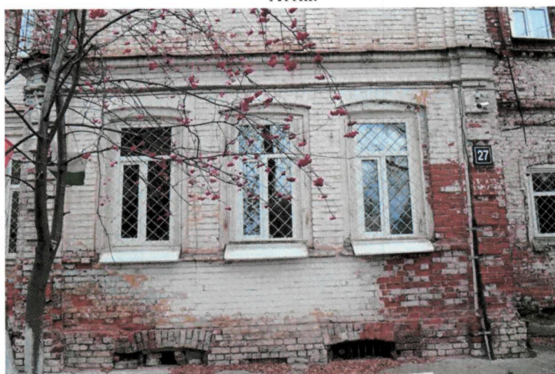
Оконные проемы 1 этажа
