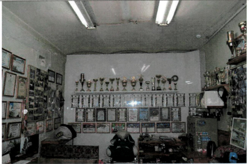
Сводчатое перекрытие подвала
