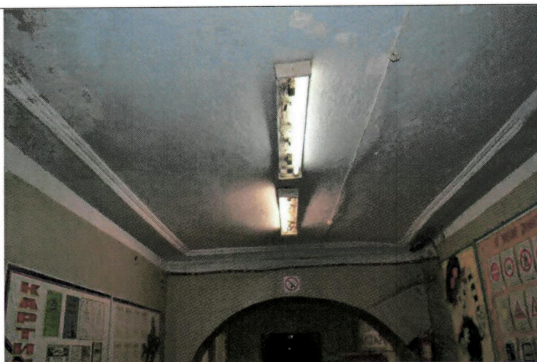
Профилированные потолочные тяги
