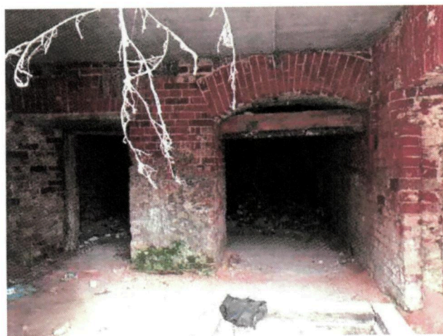
Кирпичные перемычки проемов подвала
