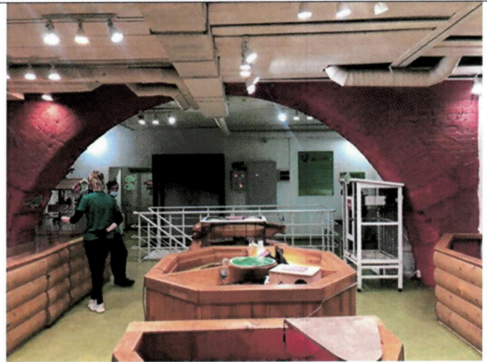
Вид стены 1 этажа с арочным проемом
