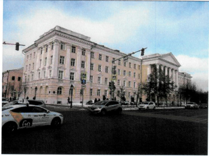
Общий вид с перекрёстка
