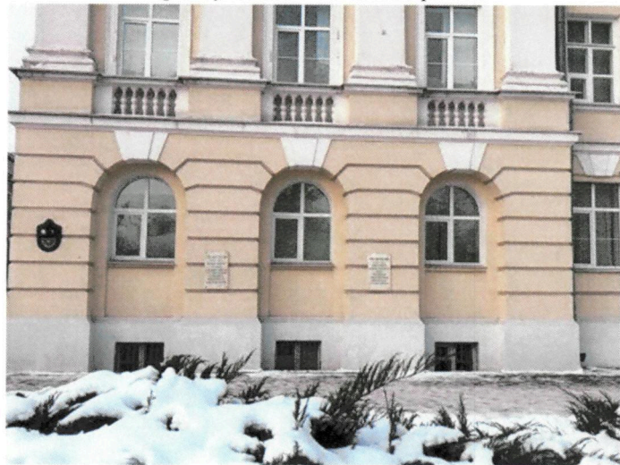
Арочные оконные проемы
