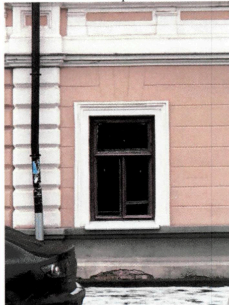
Оконный проем 1 этажа
