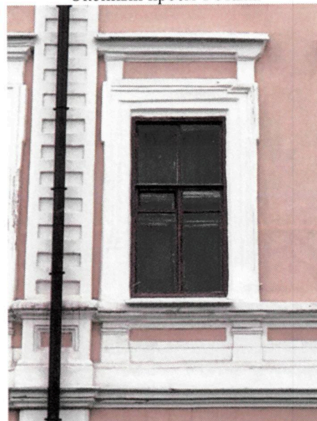
Оконный проем 2 этажа
