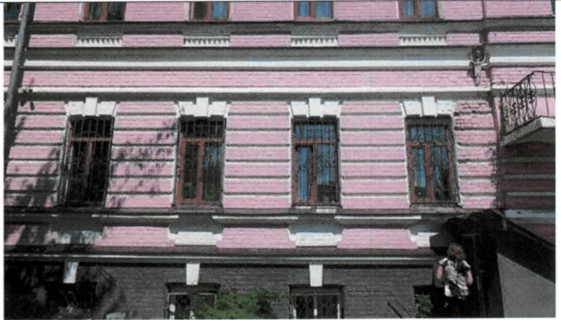
Фрагмент южного фасада.
