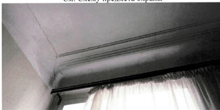
Профиль потолочной тяги в помещении первого этажа (каб. АХЧ)
