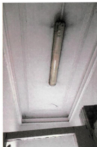
Профилированный потолок в помещении первого этажа
