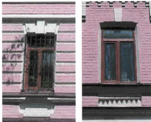
Оформление оконных проемов первого и второго этажей
