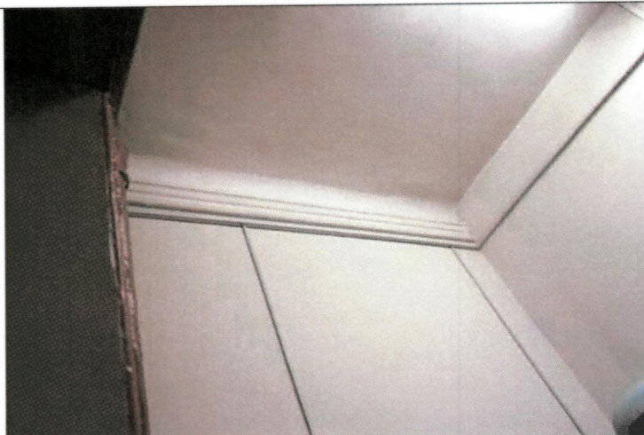
Профиль потолочной тяги в помещении подвального этажа
