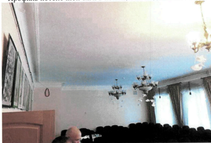
Потолочные и карнизные тяги в помещении первого этажа (актовый зал)
