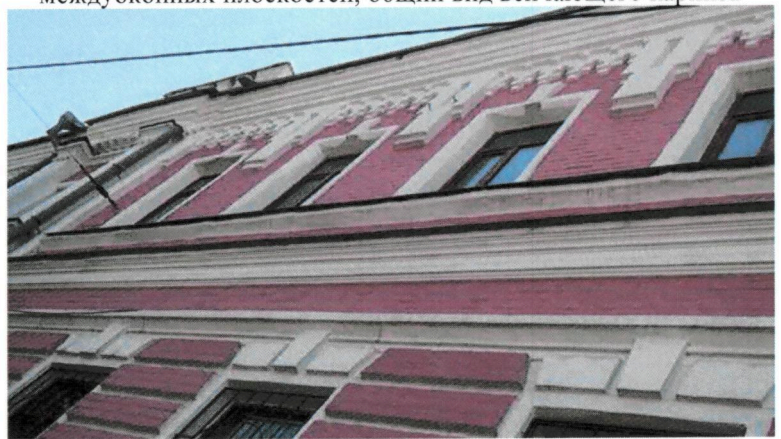
Северный фасад. Оформление междуэтажного и венчающего карниза
