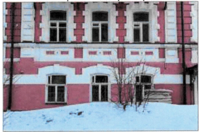
Рис 17. Руст плоскости второго этажа. Лежачие (горизонтальные) профилированные подоконные ниши с круглыми розетками. Подоконные профилированные тяги. Рустовка плоскости второго этажа
