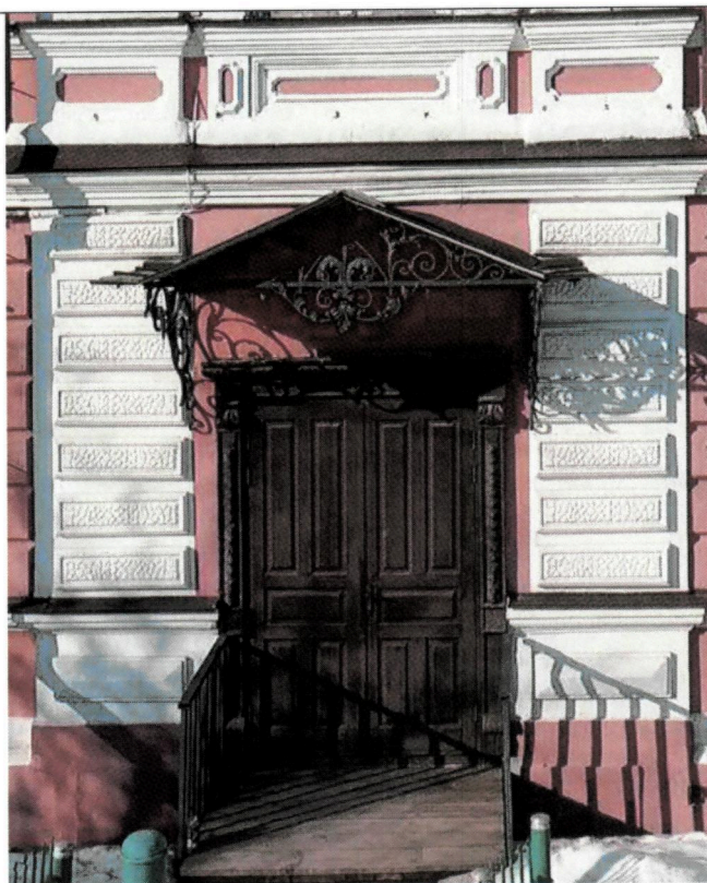
Рис 23. Металлический зонт со скатной кровлей; декоративное убранство оформления дверного проема
