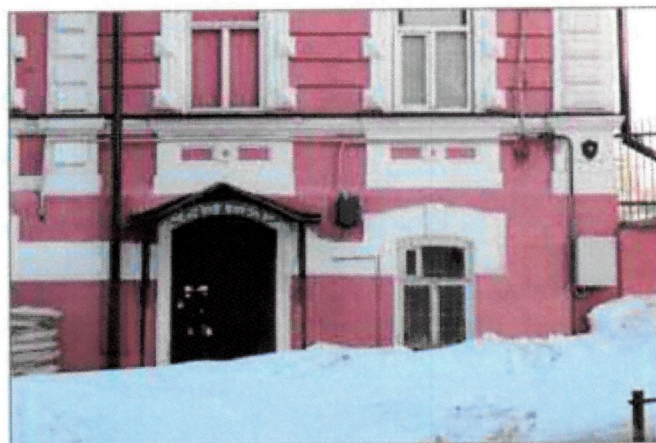
Рис 15. Штукатурный (плоский) наличник оконного проема первого этажа с замковым камнем. Металлический зонт со скатной кровлей над дверным проемом
