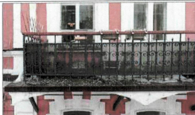
Рис 13. Металлический балкон с ажурной решеткой и трехчастным сегментным (лучковым) перекрытием на металлических опорах
