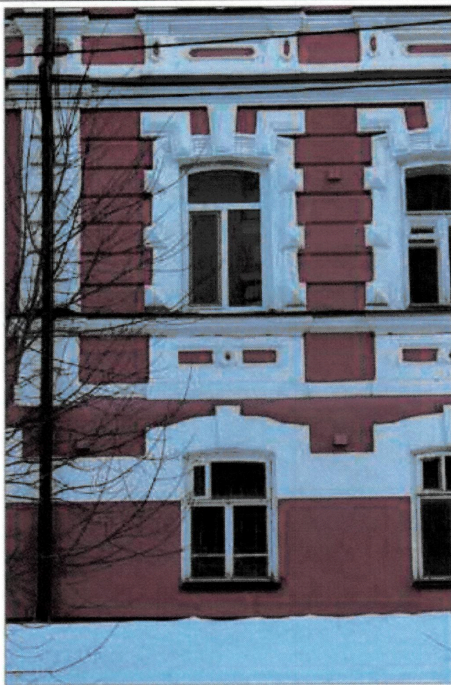
Рис 18. Профилированные наличники окон с строенными (веерными) замковыми камнями и филенками в мотивах «ананасный руст». Замковый камень оконных проемов первого этажа
