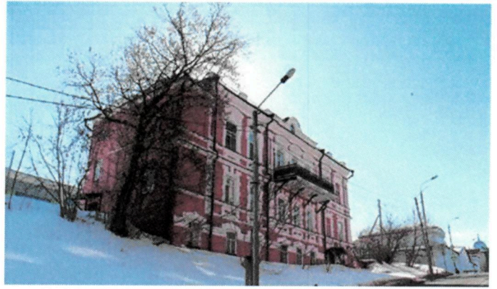
Рис 3. Архитектурно- композиционное решение главного фасада по ул. Япеева. Общий вид
