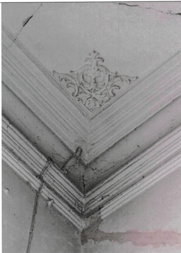
Рис 41. Галтельный карниз и лепной декор; профилированные тяги
