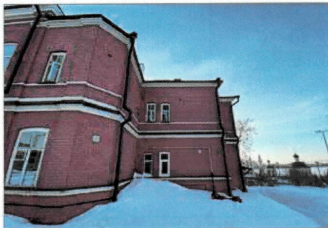
Рис 29-30. Восточный фасад; лучковая (клинчатая) перемычка межэтажные и профилированные тяги и венчающий карниз. Межэтажные профилированные тяги. Скос угла памятника
