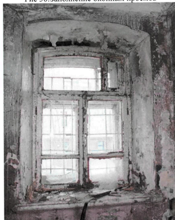
Рис 37. Оконный расцвет; раскладка столярного заполнения
