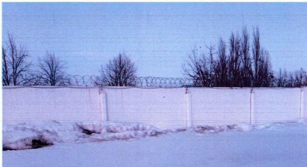
Рис. 3.2 Ограждение первого пояса ЗСО со стороны Хлебного проезда
