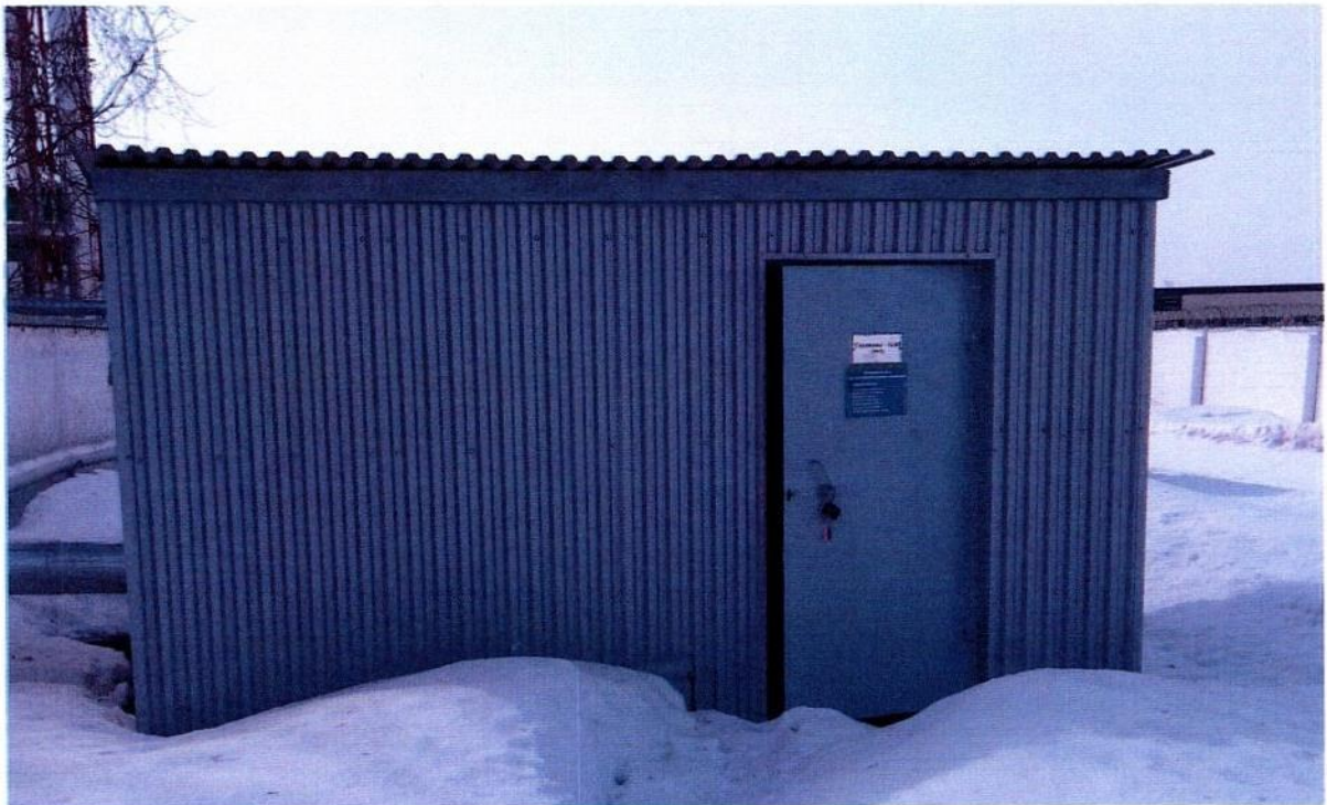
Рис. 2.1 Надкаптажное сооружение водозаборной скважины № 10/98
