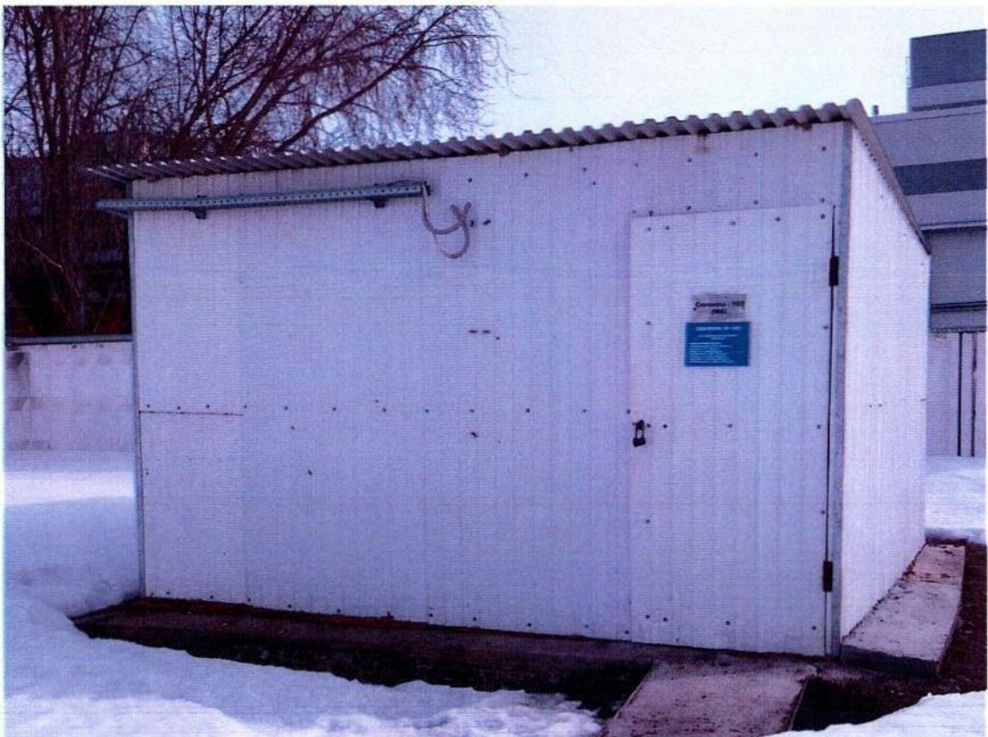
Рис. 2.3 Надкаптажное сооружение водозаборной скважины № 1/03
