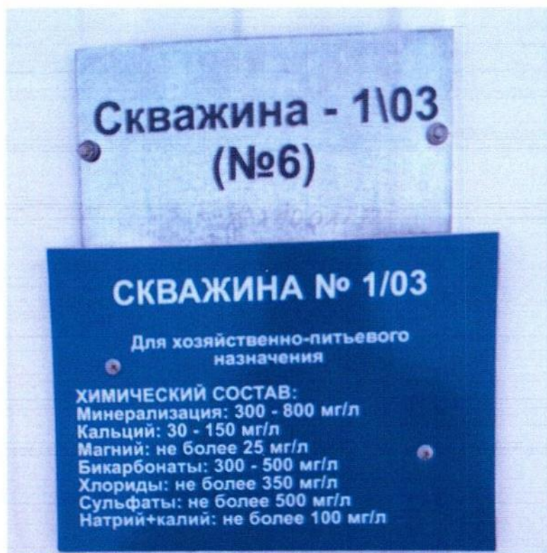
Рис. 2.4 Табличка надкаптажного сооружения скважины № 1/03
