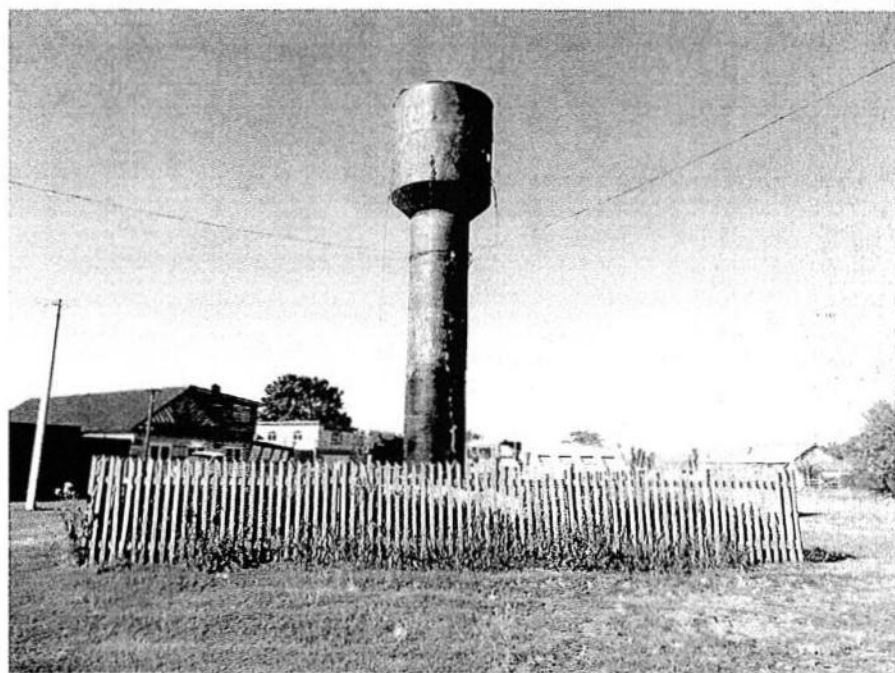
Рис. 10. Водонапорная башня в н.п.Кугушево
