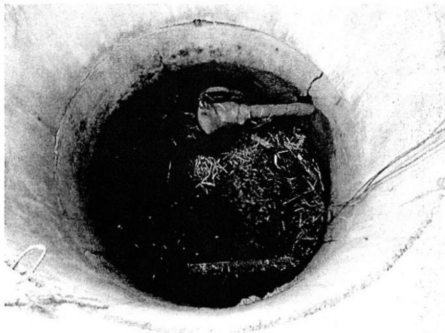
Рис.9 . . Устье скважины №1 (95) в колодце из ж/б колец
