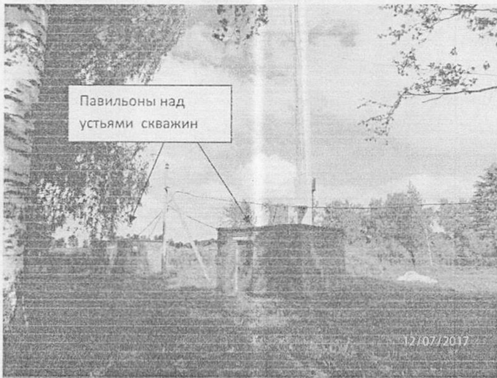
Рис.7 . Водозабор ООО «Аква-Трейд» в н.п.Кукмор
