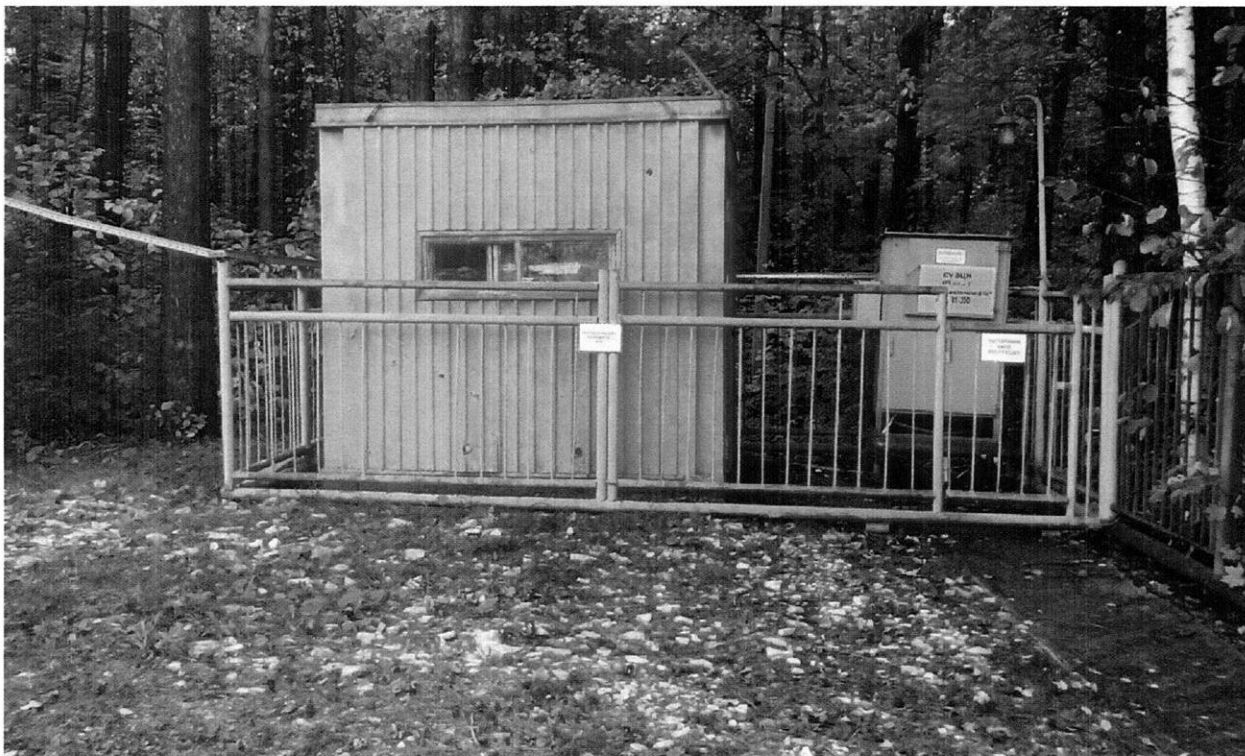
Рис.6.1. Павильон скважины №4 с внутренним ограждением в границах 1-го пояса ЗСО
