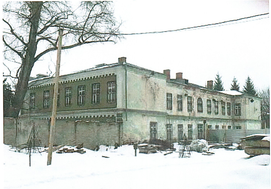
Общий вид со стороны двора
