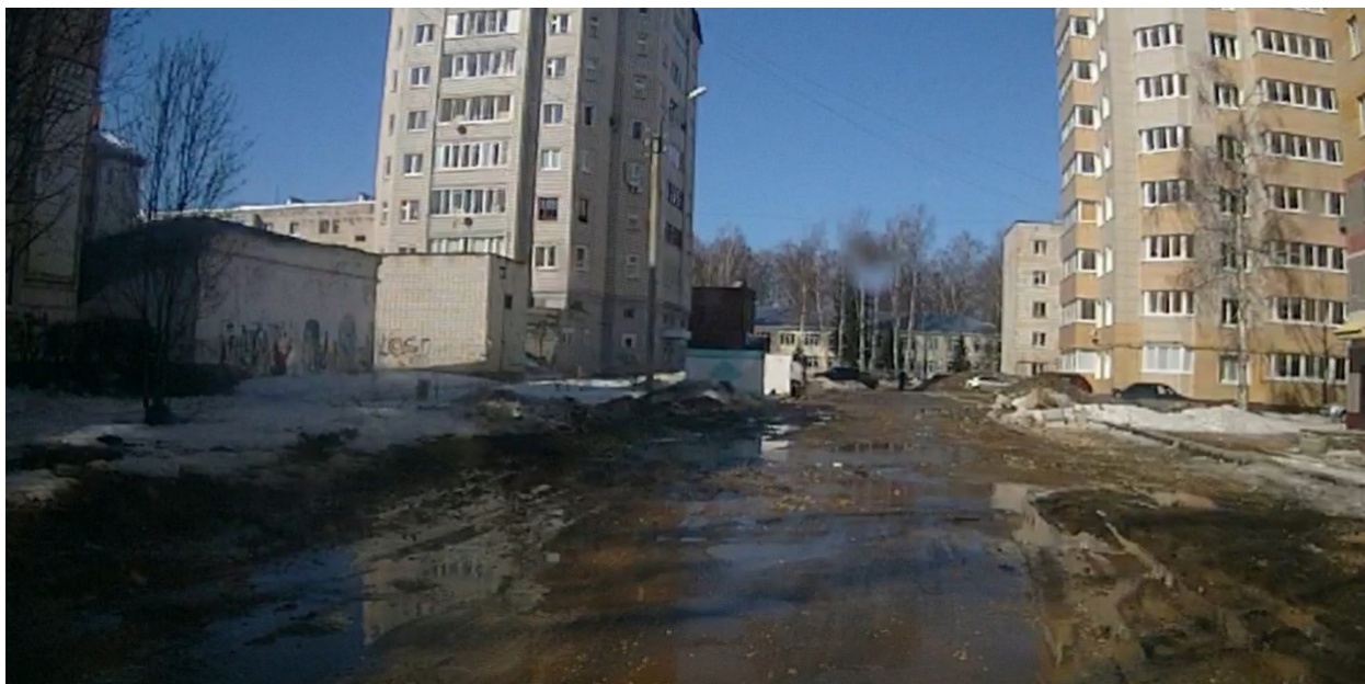
Рисунок 31 – Пример состояния автомобильной дороги местного значения
