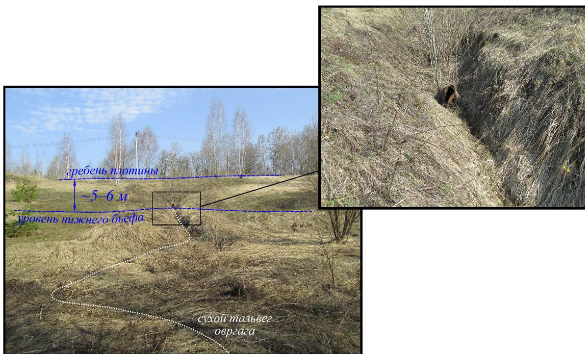
Фото 3.3.2 - Земляная насыпь в южной части пруда и недействующий водопропуск (май, 2018 г.).
