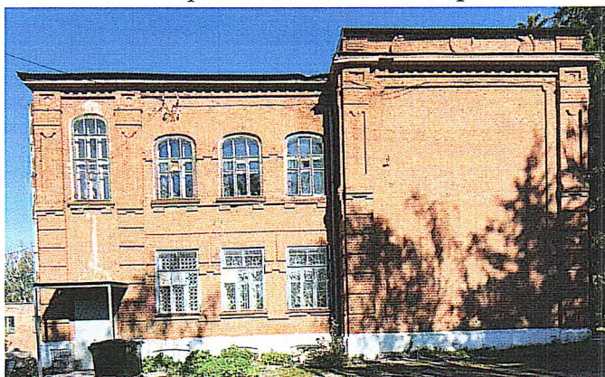
Рис. 8. Юго-западный боковой фасад
