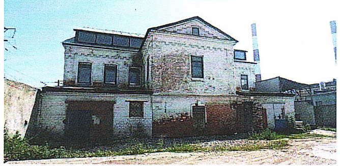
Рис.19. Крыша со стороны дворового фасада
