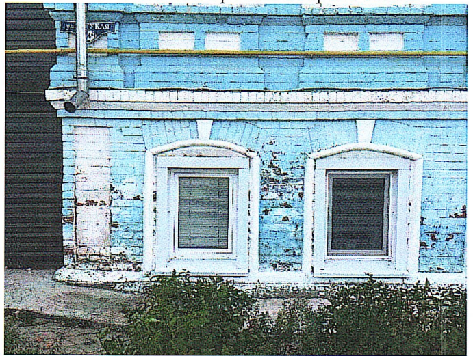
Рис.8. Оконные проемы первого этажа
