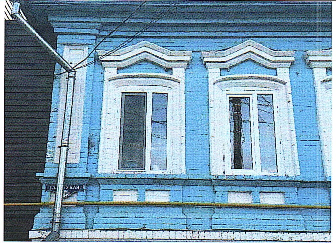
Рис.7. Оконные проемы второго этажа
