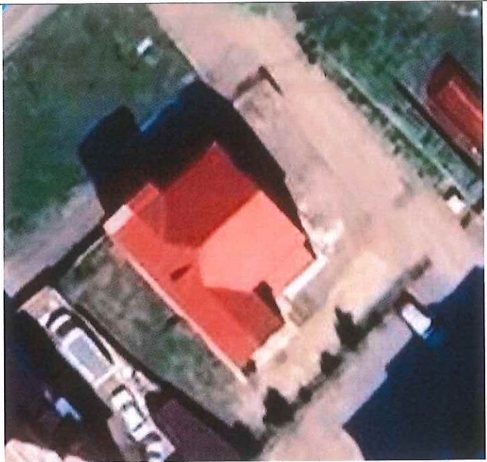
Рис. 3. Вид крыши здания на аэрофотоснимке
