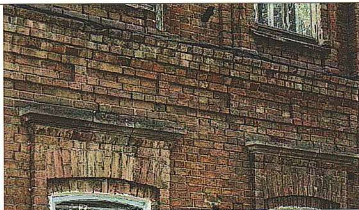
Рис. 9. Фрагмент фасада, кирпичная кладка
