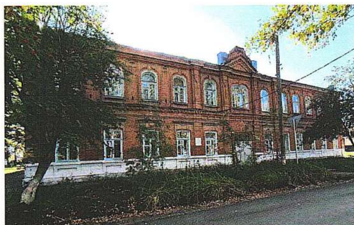
Рис. 5. Фасад по улице Гоголя.
