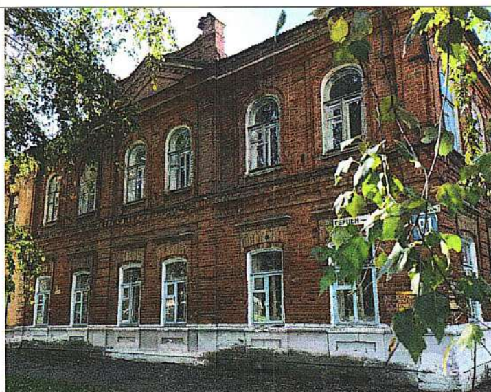
Рис. 4. Фасад по улице Герцена.
