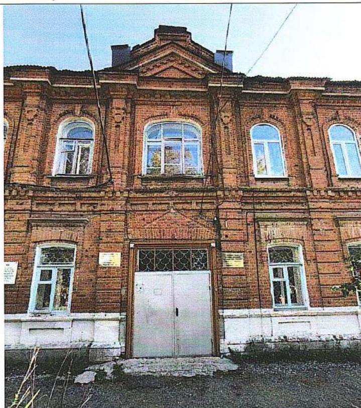
Рис. 6. Фрагмент фасада по улице Гоголя, входная часть.
