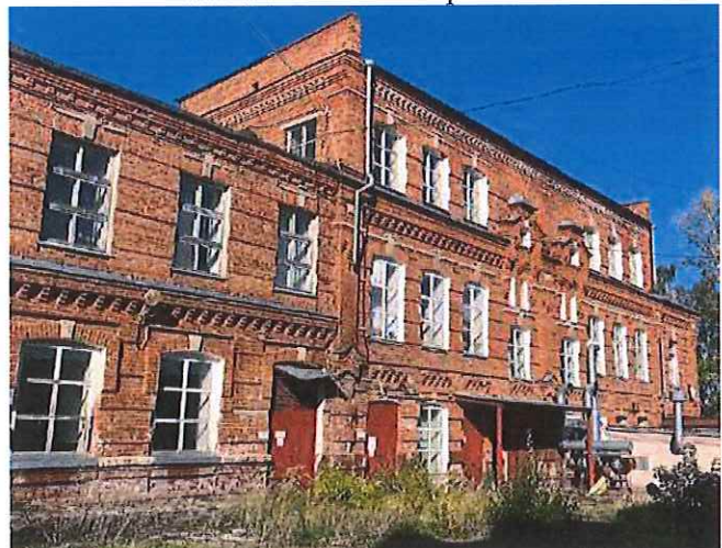
Рис.7. Вид на северо-восток
