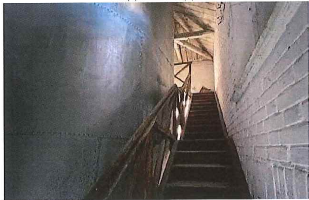
Рис.11. Деревянная лестница на антресольный этаж «Здания Цистерн»
