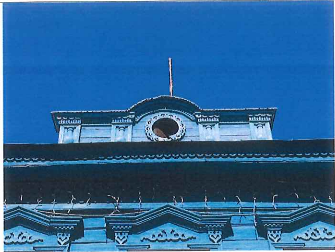
Рис. 6. Венчающий карниз. Деревянный аттик со слуховым окном.
