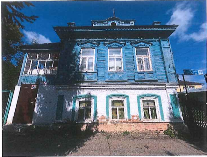
Рис. 3. Главный фасад по улице Энгельса
