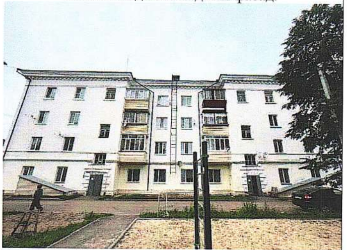
Рис.18. Вид на дворовой (южный) фасад.
