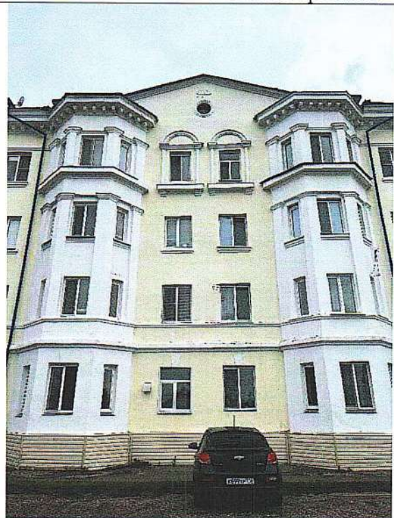
Рис.24. Главный фасад по улице Урицкого. Эркеры.
