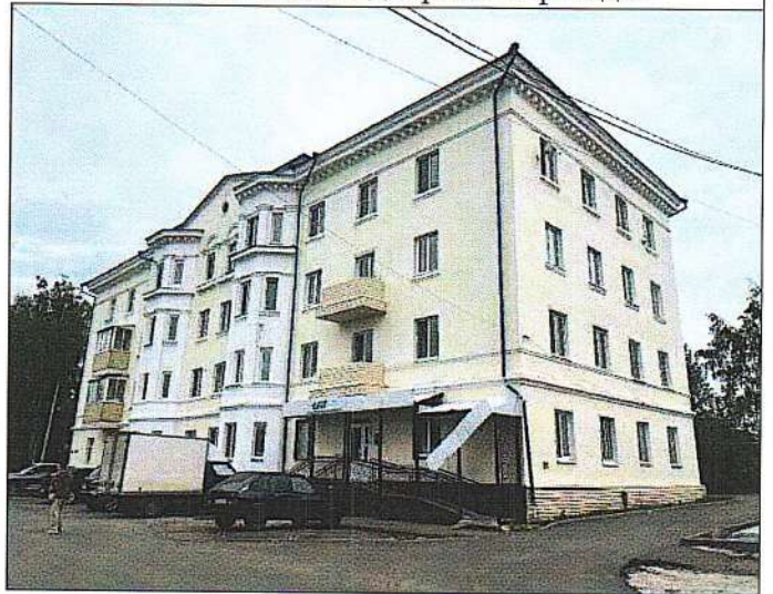
Рис.26. Балконы главного фасада.
