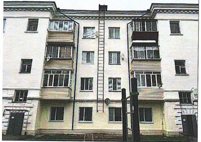
Рис.25. Балконы дворового фасада.
