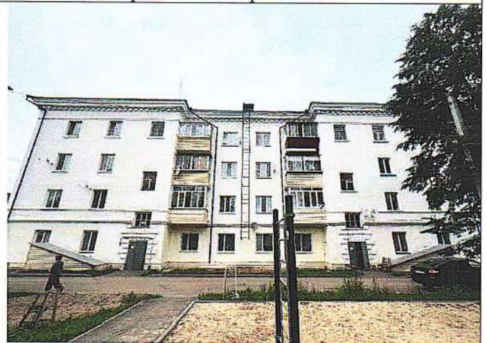
Рис.8. Крыша. Дворовой фасад.
