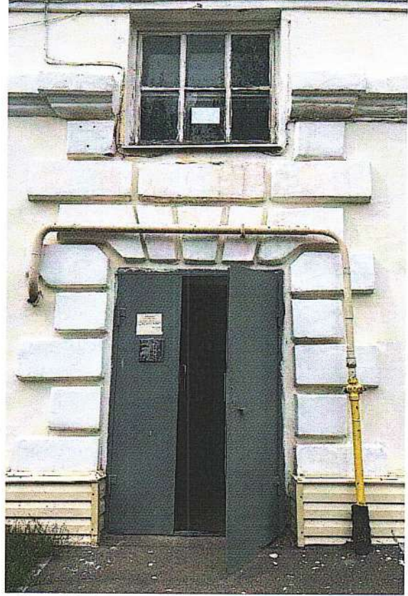
Рис.23. Заполнение оконных проемов.
