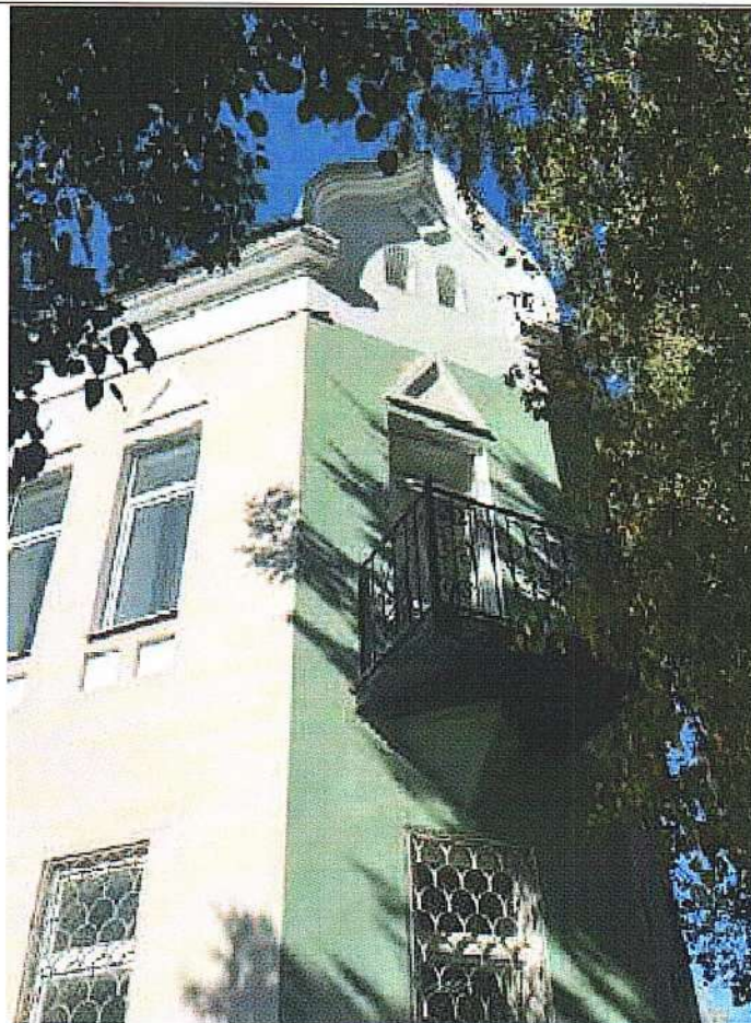
Рис.6. Вид в северо-западном направлении на оформление углового фасада здания. декорированного килевидным щипцом
