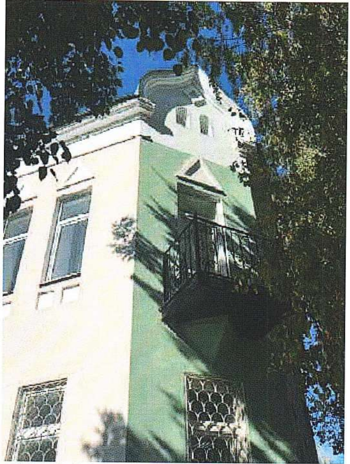
Рис.18. Вид в северо-западном направлении. Балкон
