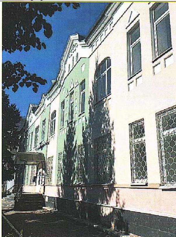
Рис.7. Вид в северо-западном направлении с ул. Я. Гашека на главный фасад дома. Арочные оконные проемы
