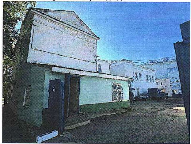
Рис.4. Вид в южном направлении на дворовый фасад здания почты с современной хозяйственной пристройкой
