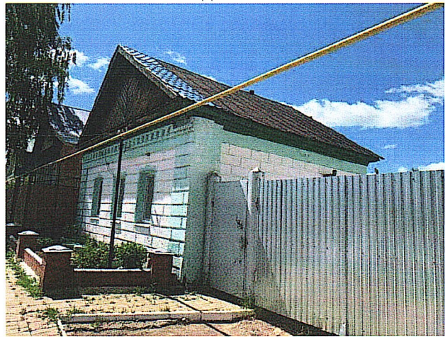
Рис. 4. Здание почтовой конторы
