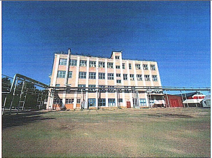
Рис.6. Вид с юго-запада
