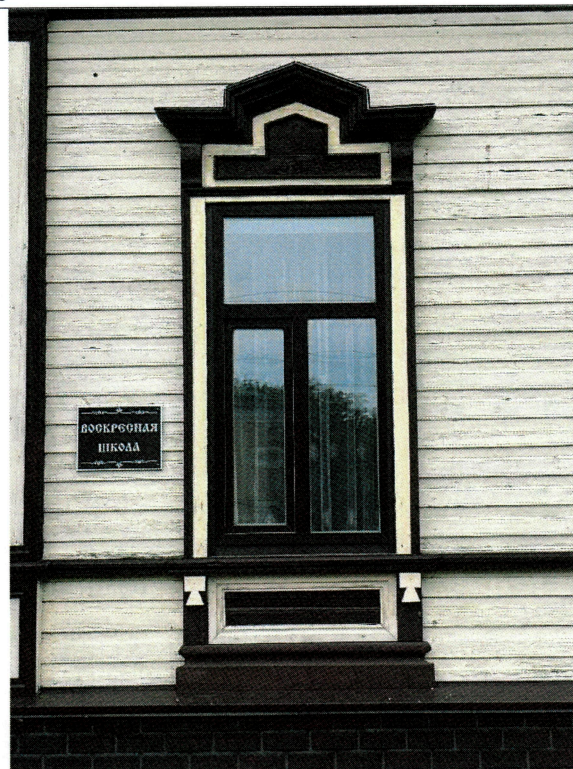
Рис.9. Оконный проем с наличником, подоконной филенкой (фартуком) и сандриком. Фланкирующая причелина.
