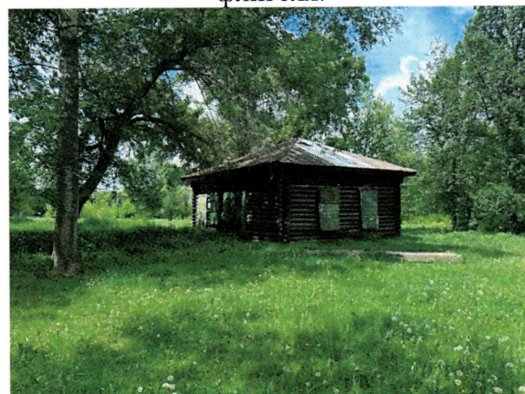
Рис. 11. Современное состояние деревянного флигеля.
