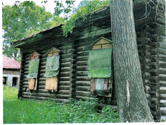
Рис. 7. Современное состояние деревянного флигеля.
