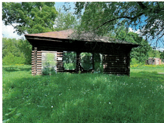
Рис. 10. Современное состояние деревянного флигеля.
