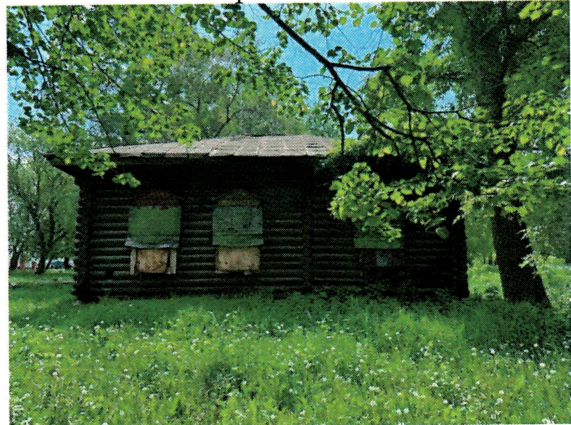
Рис. 8. Современное состояние деревянного флигеля.
