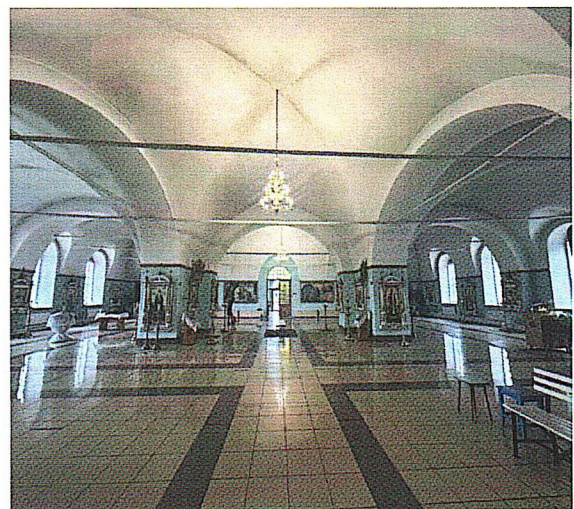
Рис. 10. Современное состояние интерьера. Сводчатая система перекрытий.
