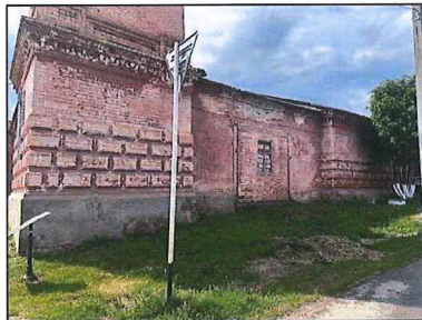
Рис. 10. Фрагмент фасада объекта исследования
