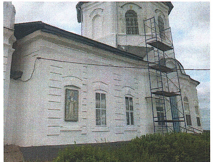
Рис. 9. Вид с юго-запада
