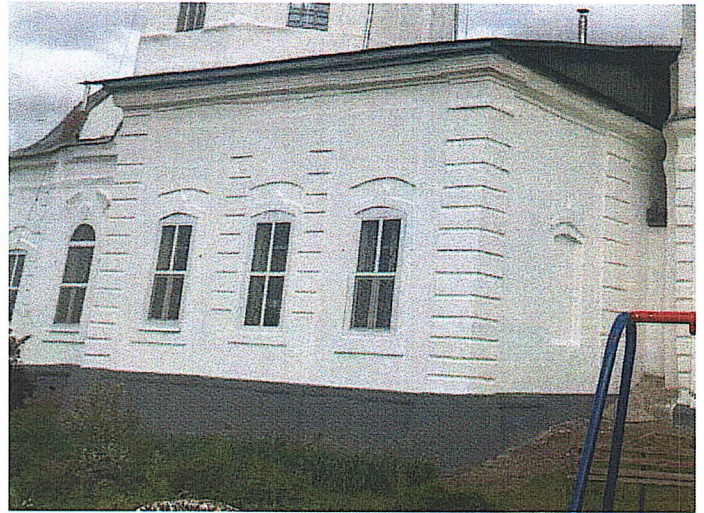
Рис. 7. Вид с севера
