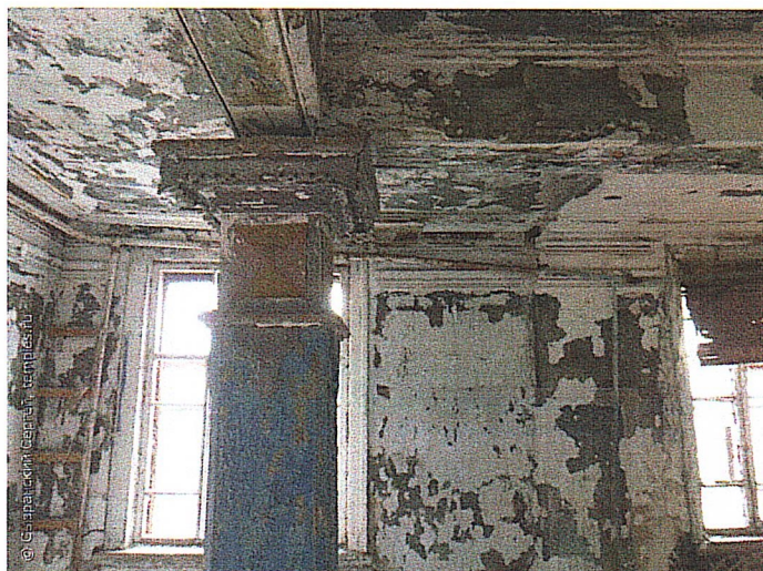
Рис. 15. Деревянная колонна
