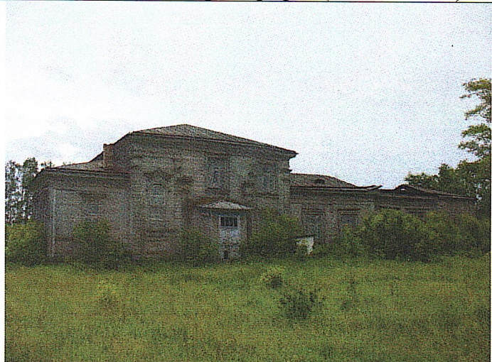
Рис. 5. Вид с севера
