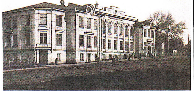
Рис. 25. Исторические оконные заполнения (архивная фотография)
