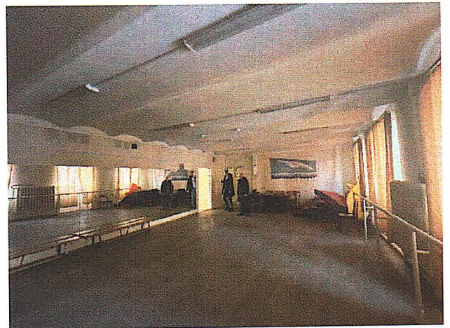
Рис. 5. Сводчатое перекрытие подвала
