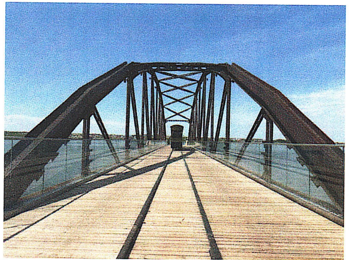
Рис. 4. Общий вид. Конструкции фермы с клепками
