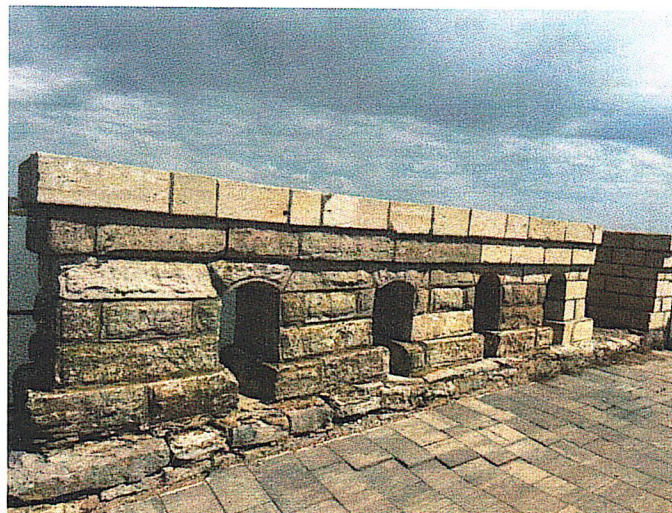
Рис. 6. Верхняя часть опоры, карниз, проемы с лучковым очертанием и замковым камнем бойниц
