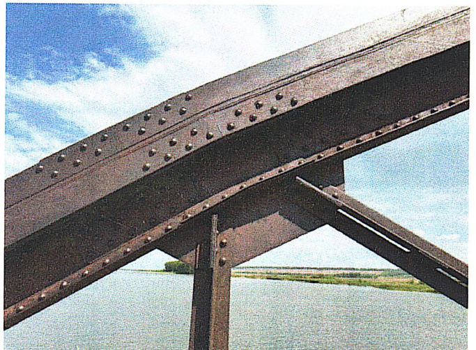
Рис. 5. Конструкции фермы с клепками
