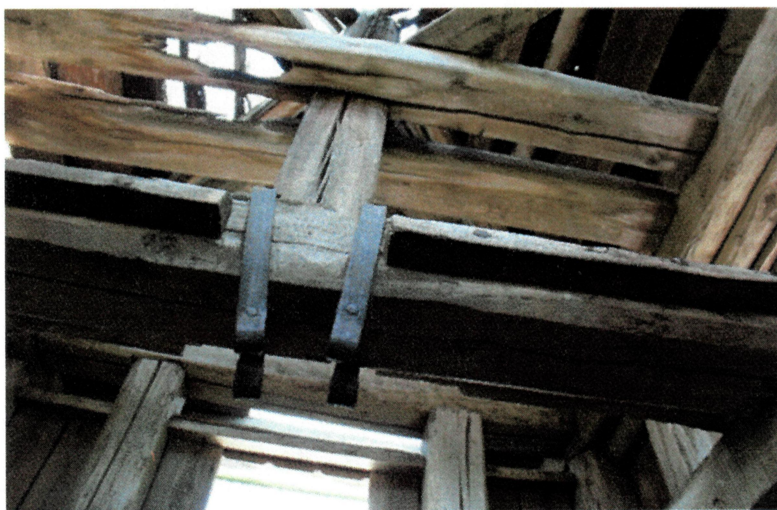
Рис. 21. Колокольня, второй ярус. Фрагмент главного направляющего элемента конструкции шатра
