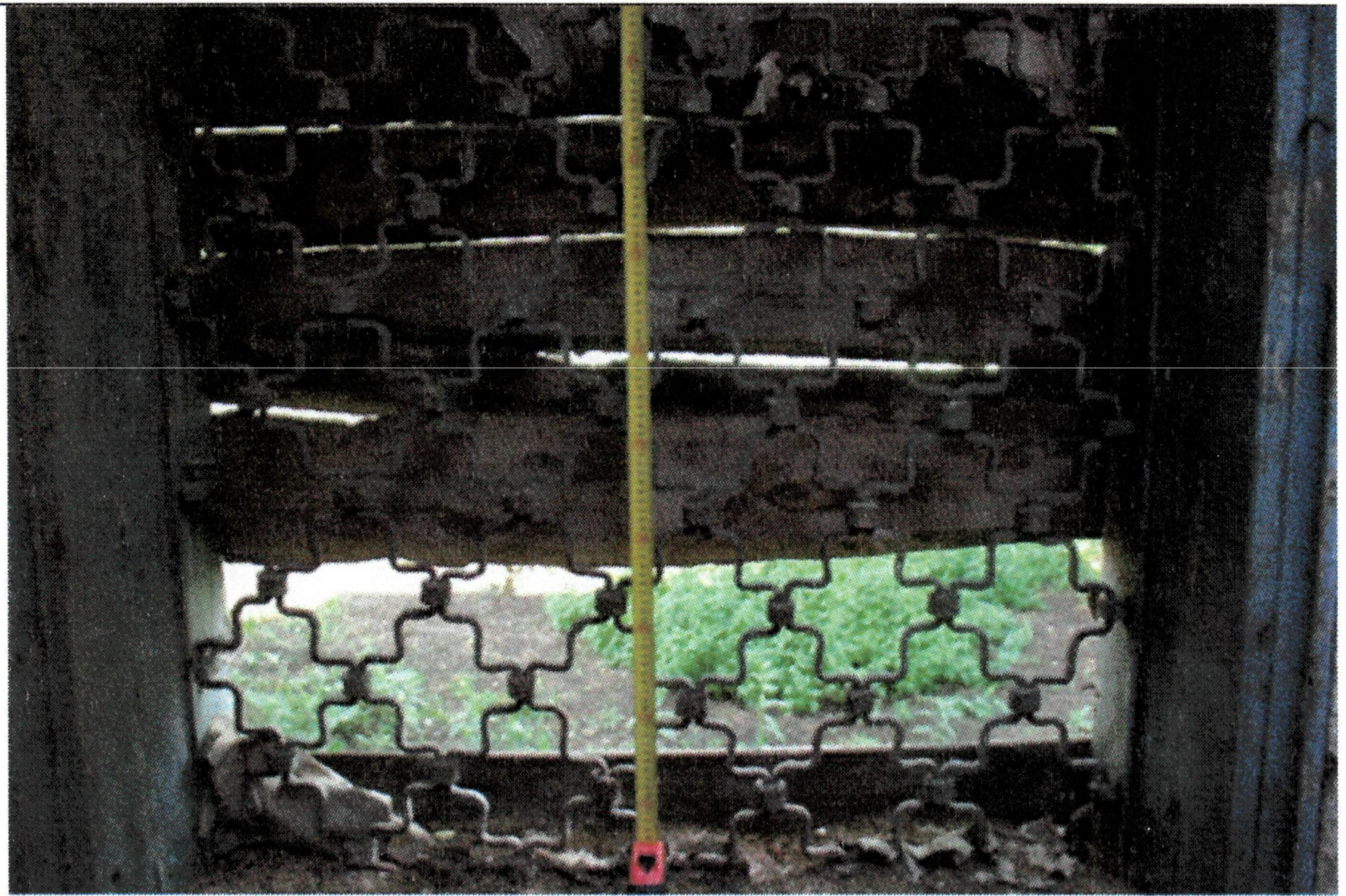
Рис. 61. Фрагмент металлической декоративной решетки в оконном проеме апсиды
