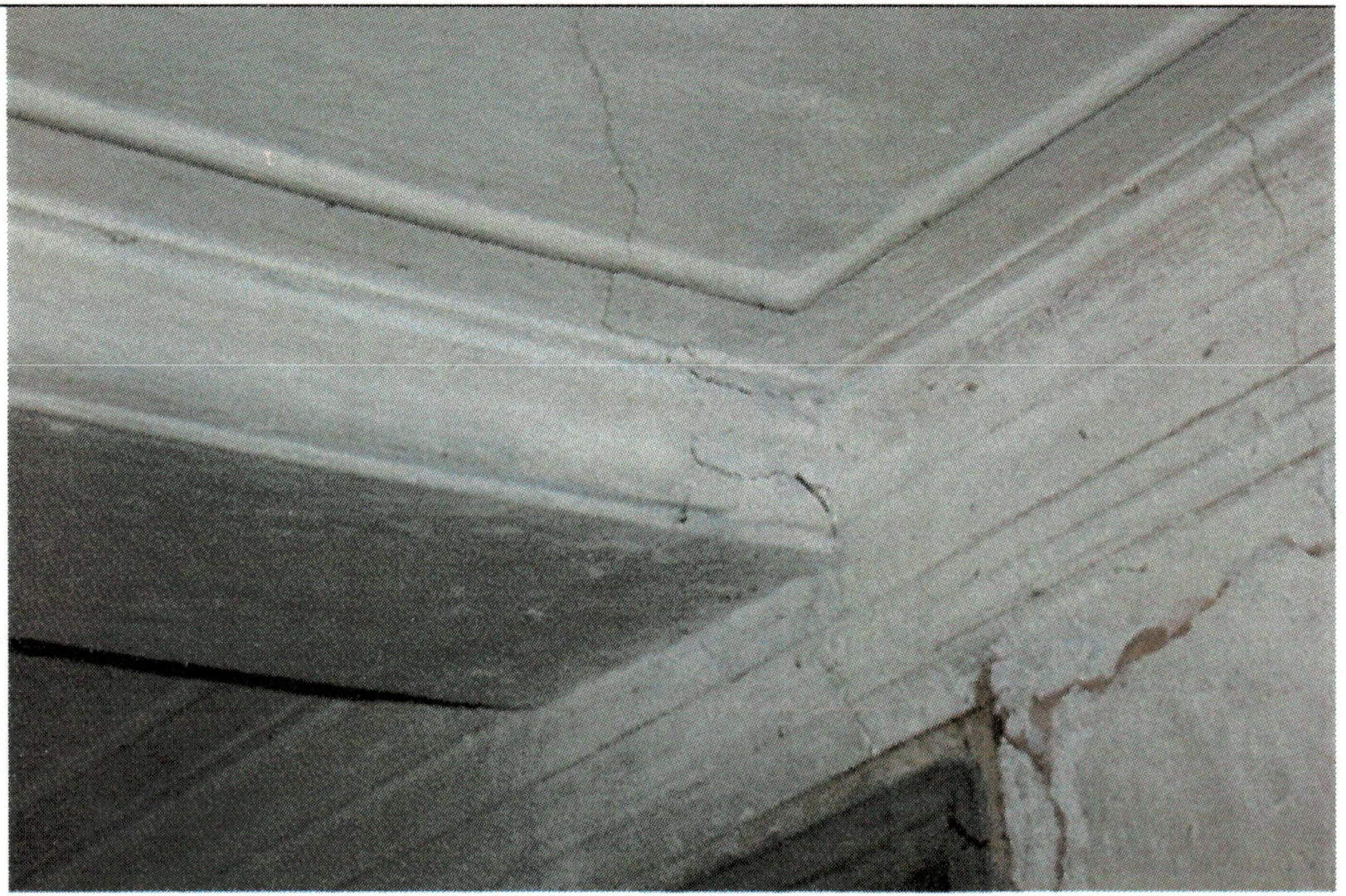
Рис. 52. Кессонированные потолочные балки храмовой части
