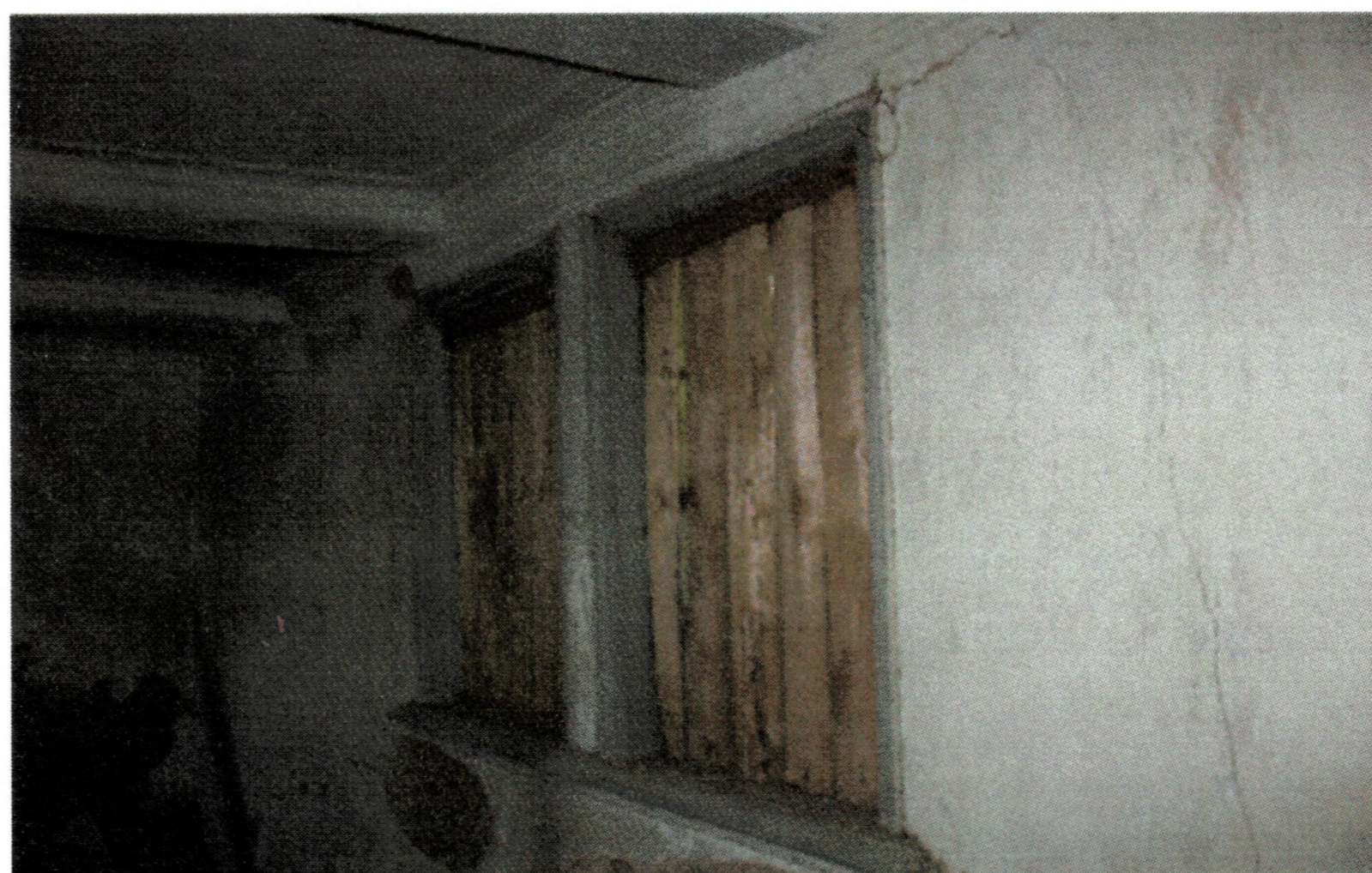
Рис. 59-60. Наличники и подоконники оконных проемов второго света храмовой части
