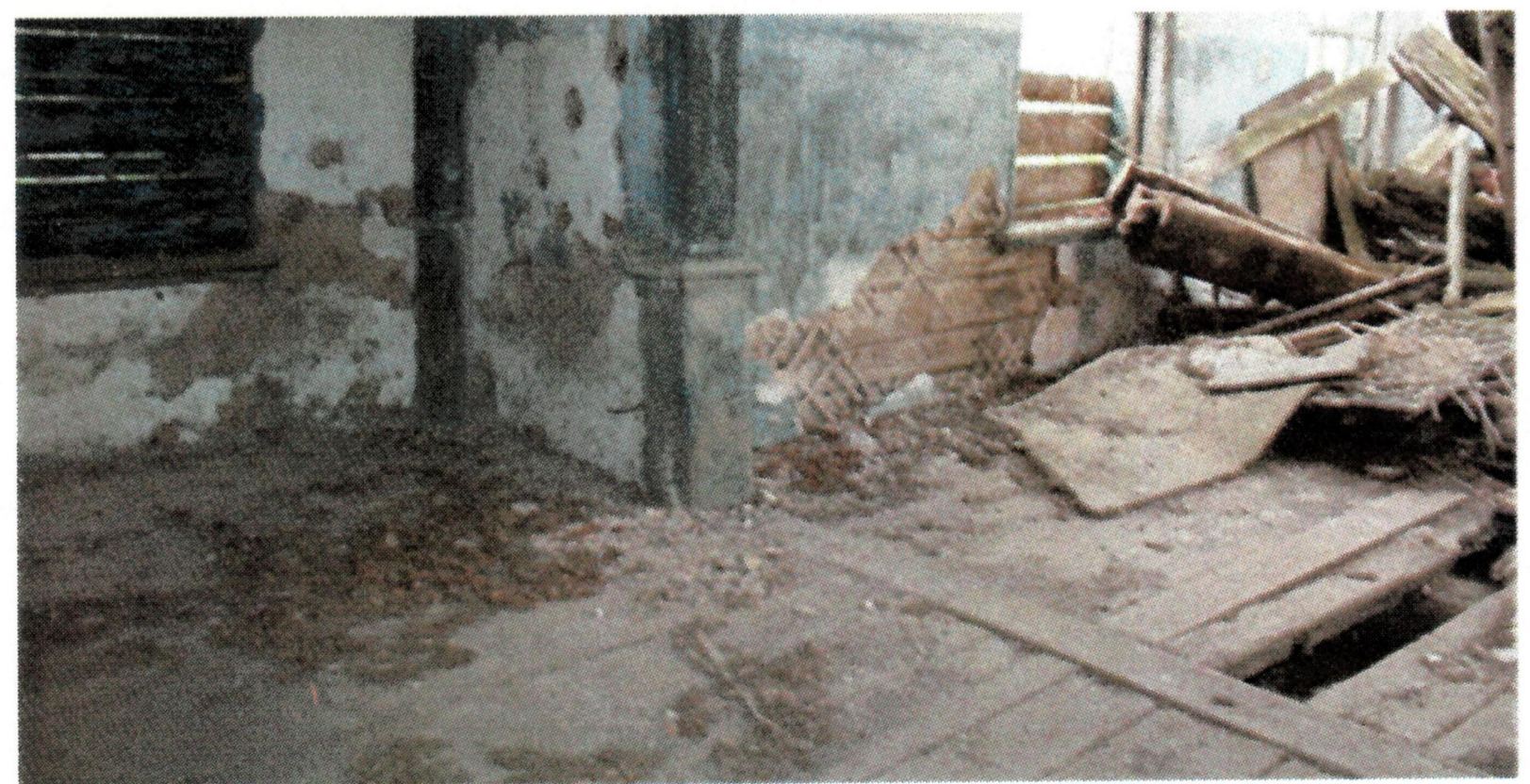
Рис. 53-54. Историческое дощатое напольное покрытие
