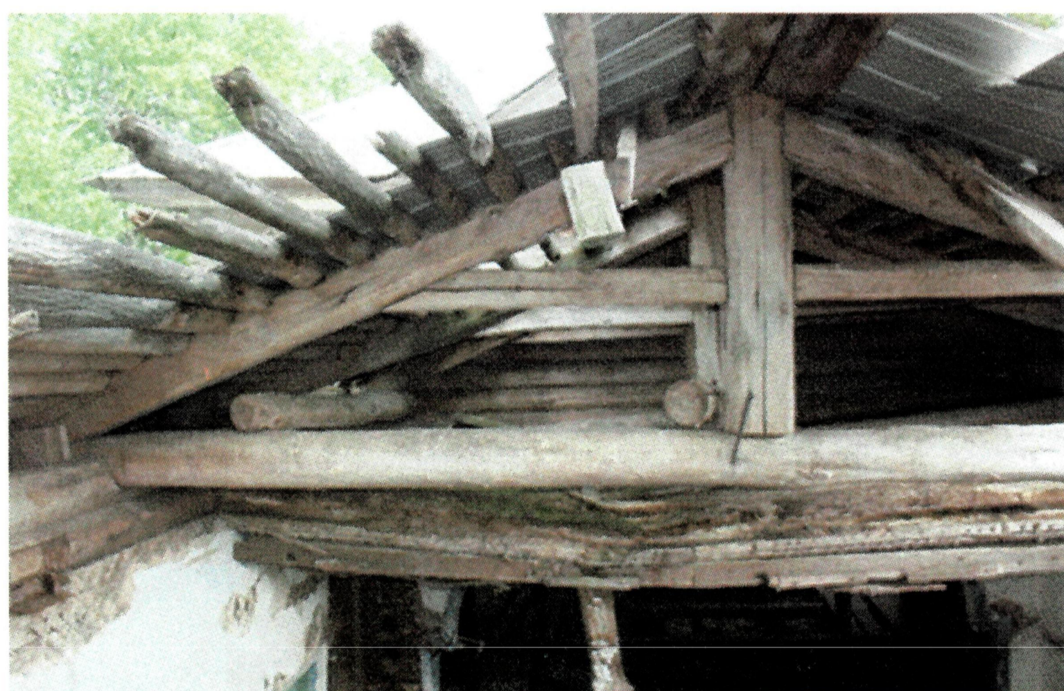
Рис. 17. Трапезная. Конструктивное решение крыши
