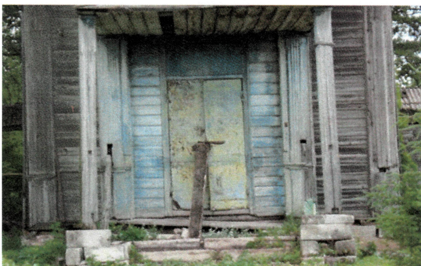
Рис. 29. Лопатки, акцентирующие главный западный вход, стилизованные под пилястры с каннелюрами от базы до верха, с полочками в нижней и верхней частях
