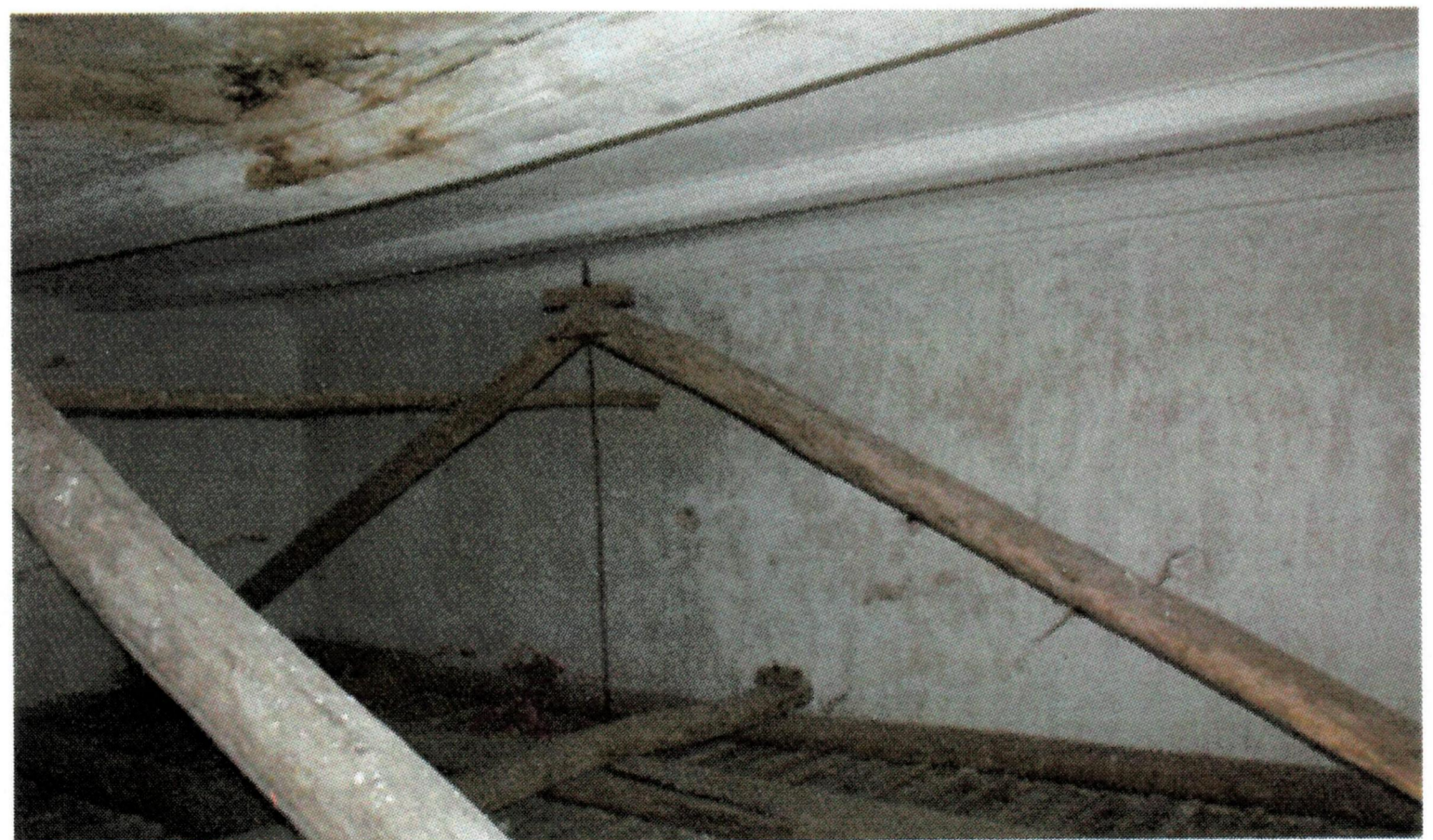
Рис. 15. Плоские деревянные перекрытия. Потолок храмового четверика
