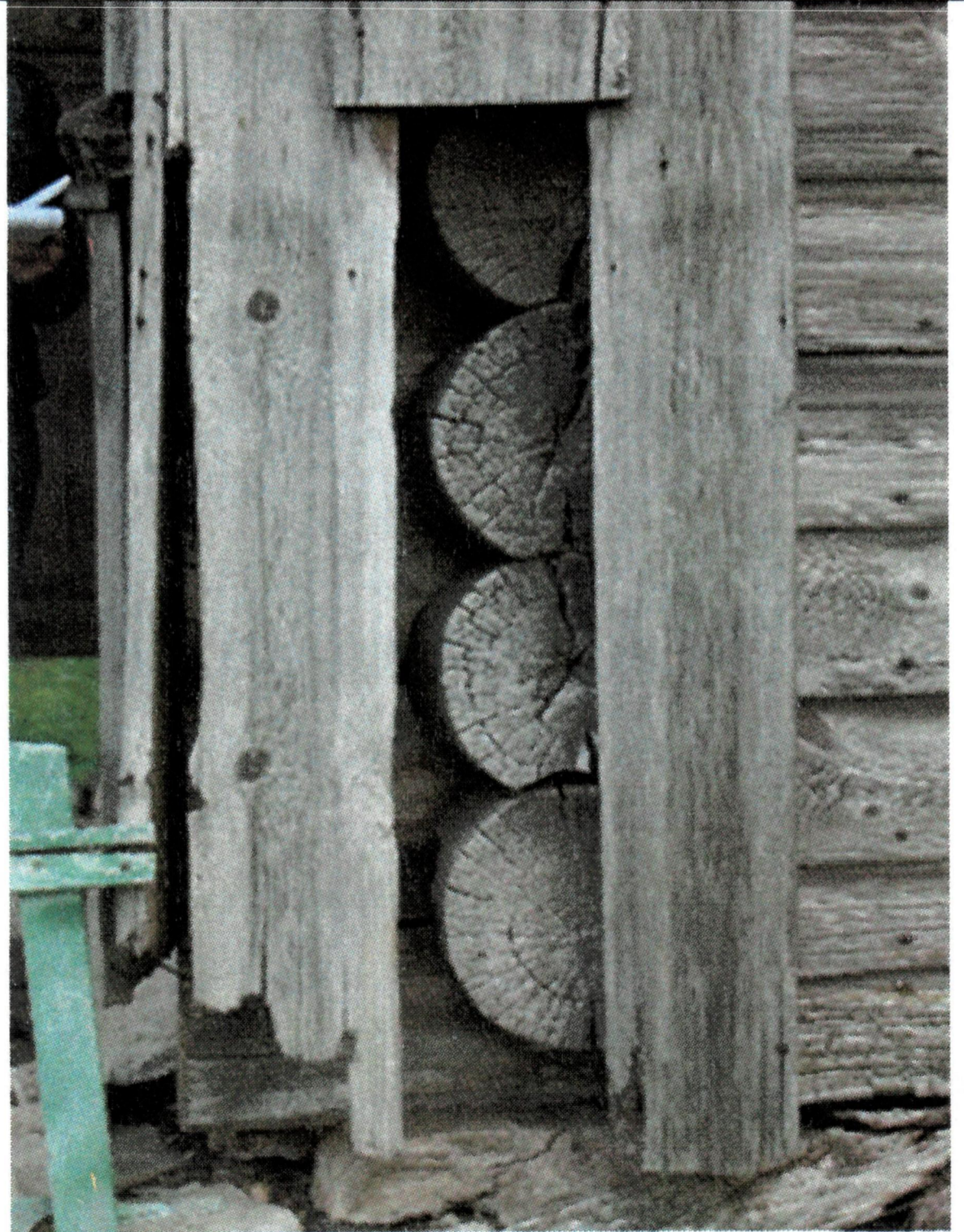
Рис. 7. Срубные бревенчатые стены. Фрагмент южного фасада 1-го яруса колокольни (притвор)
