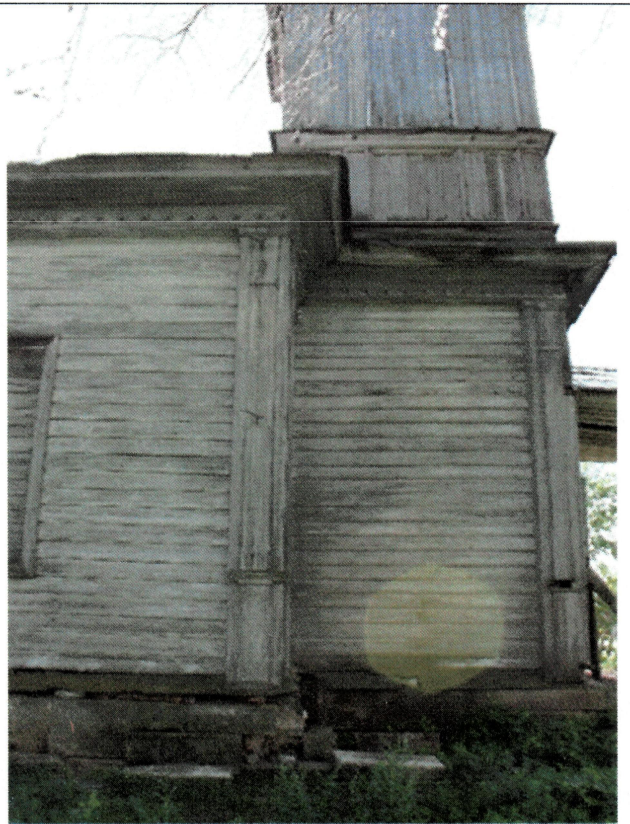
Рис. 13. Цоколь, выложенный из тесаных крупных блоков природного камня. Фрагмент северного фасада
