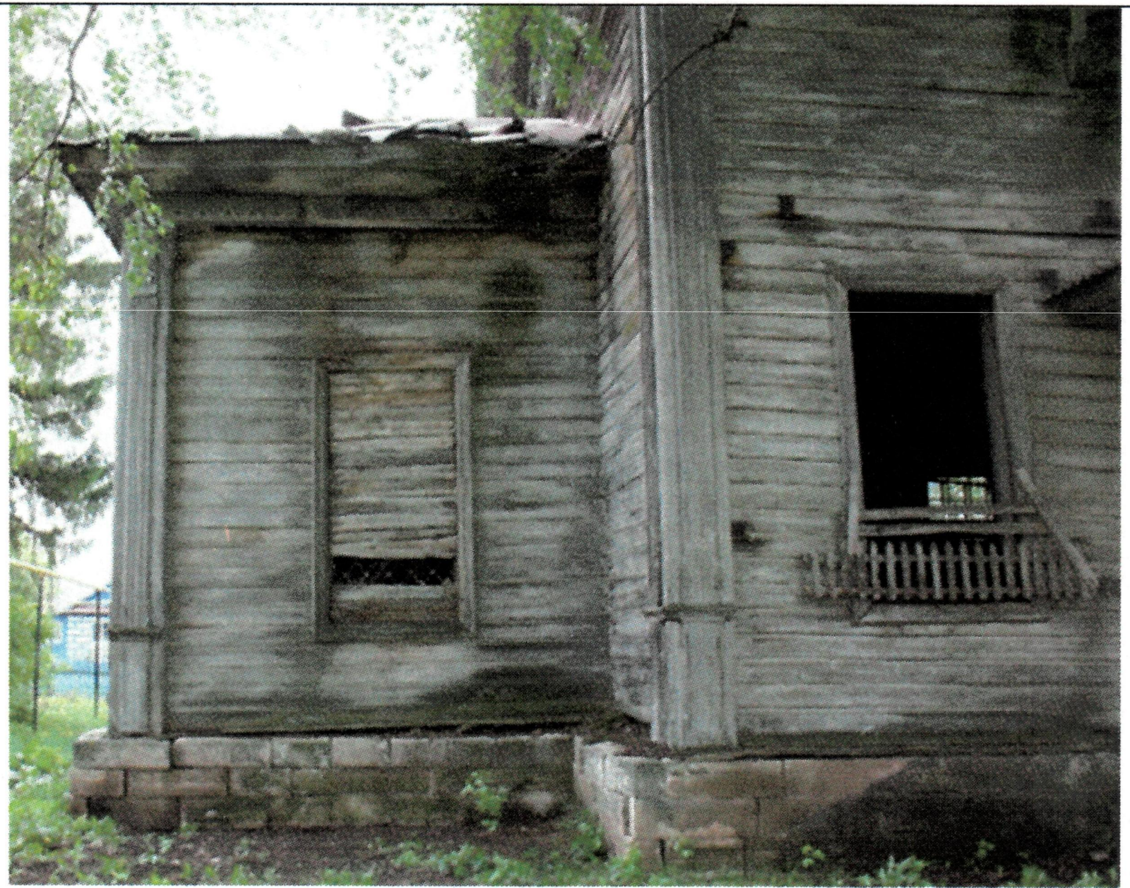
Рис. 24. Рамочные профилированные наличники в обрамлении оконных проемов храмовой части и апсиды
