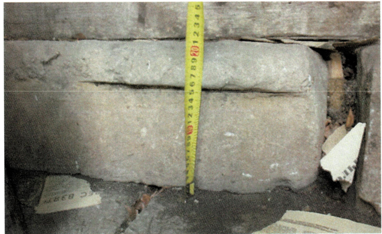
Рис. 40-42. Профилированные ступени из природного камня западного, северного и южного крылец
