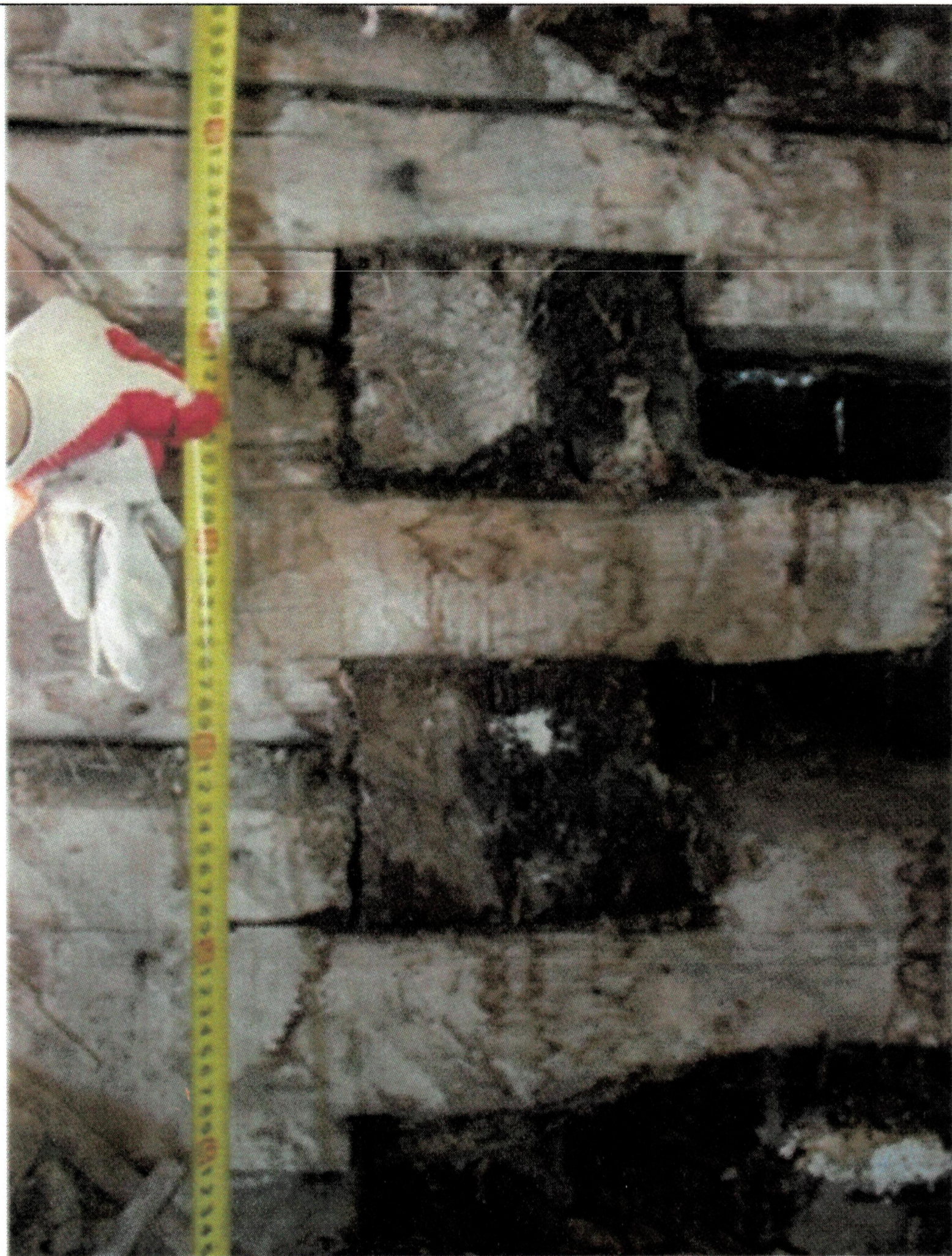
Рис. 8. Фрагмент стены арки между трапезной и храмовой частью
