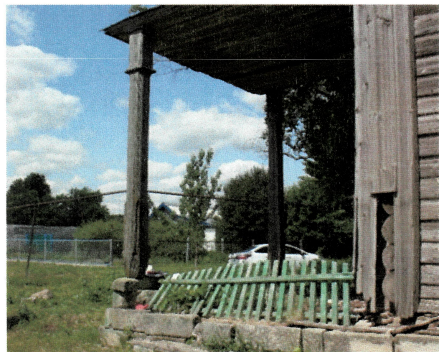
Рис. 38-39. Декоративные профилированные пояски/карнизы деревянных навесов западного, северного и южного крылец на столбах прямоугольных в плане, со стесанными углами в центральной части и декоративными деталями простого профиля в верхней
