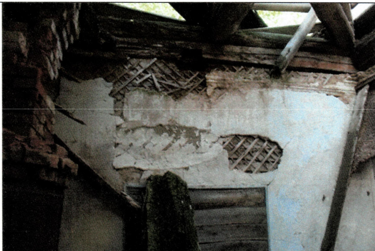
Рис. 46-49. Стесанные срубные бревенчатые стены и потолки, оштукатуренные по дранке под покраску в первом ярусе колокольни – притворе, трапезной, храмовой части и апсиде
