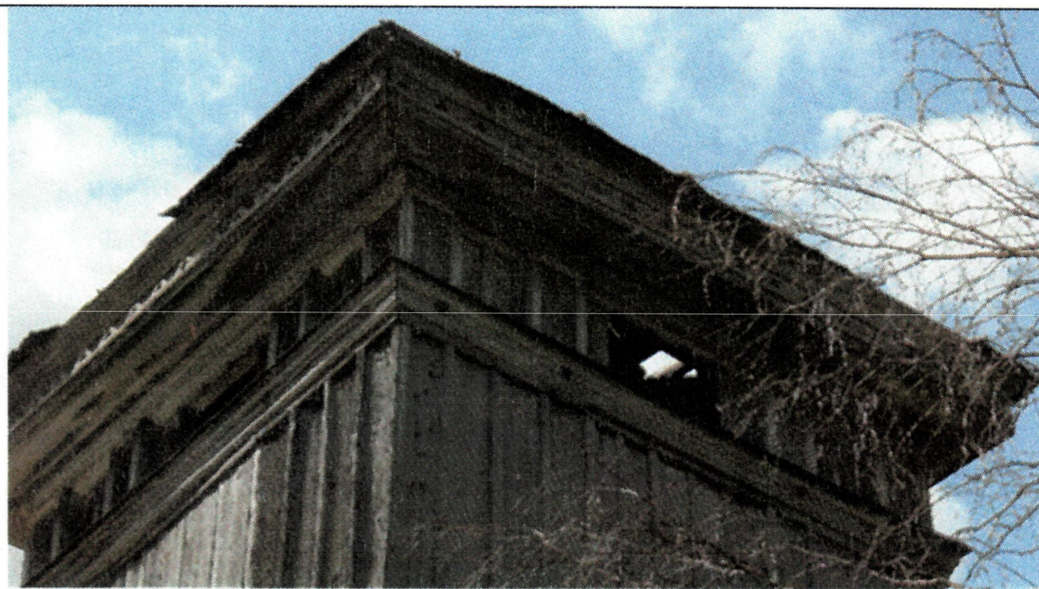
Рис. 37. Венчающий карниз колокольни, оформленный мелкими прорезными декоративными элементами в виде трилистников
