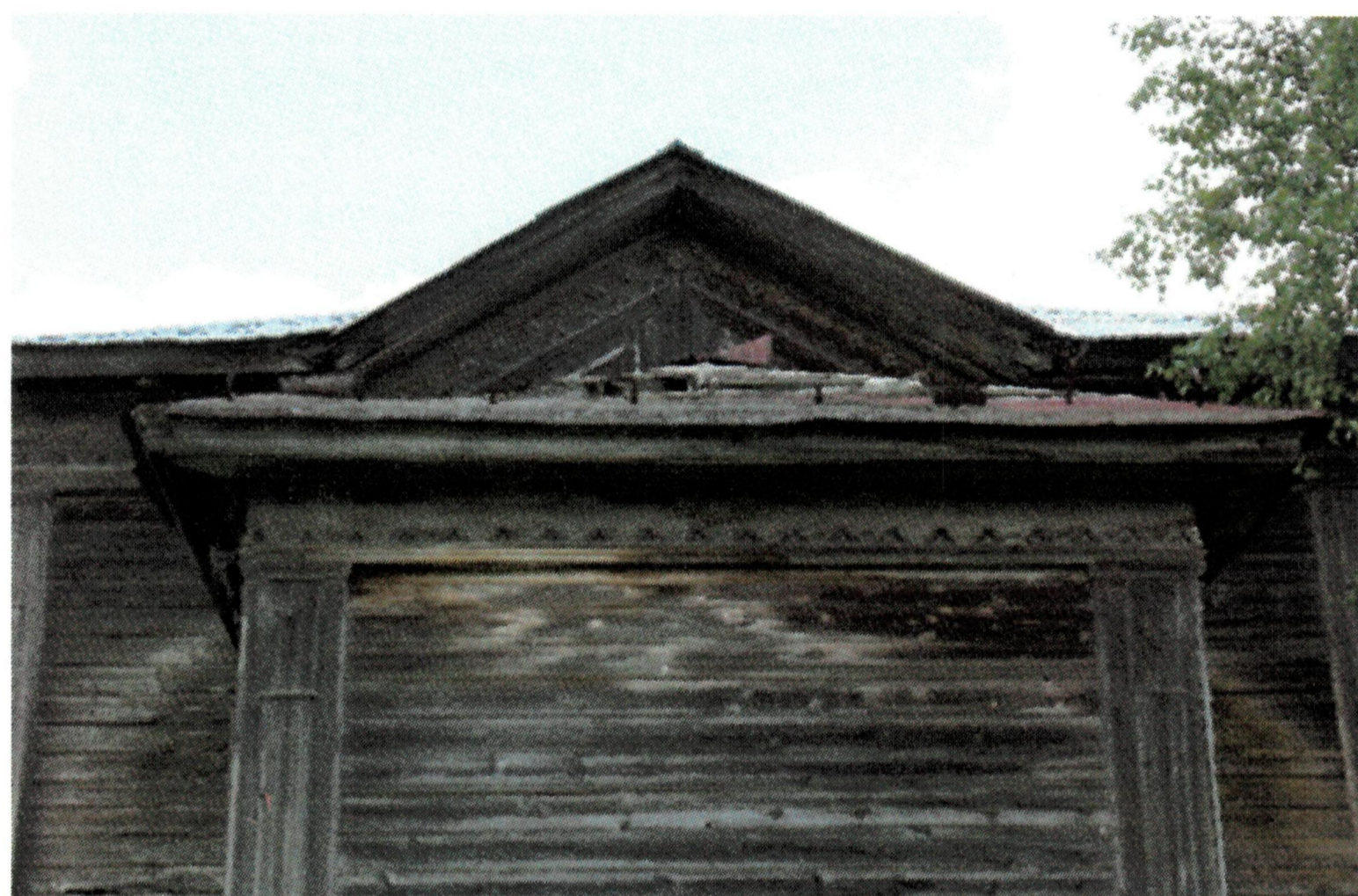
Рис. 31-32. Декоративные профилированные пояса/карнизы; фриз 1-го яруса колокольни, трапезной, апсиды, оформленный мелкими прорезными декоративными элементами в виде трилистников; венчающий профилированный карниз большого выноса
