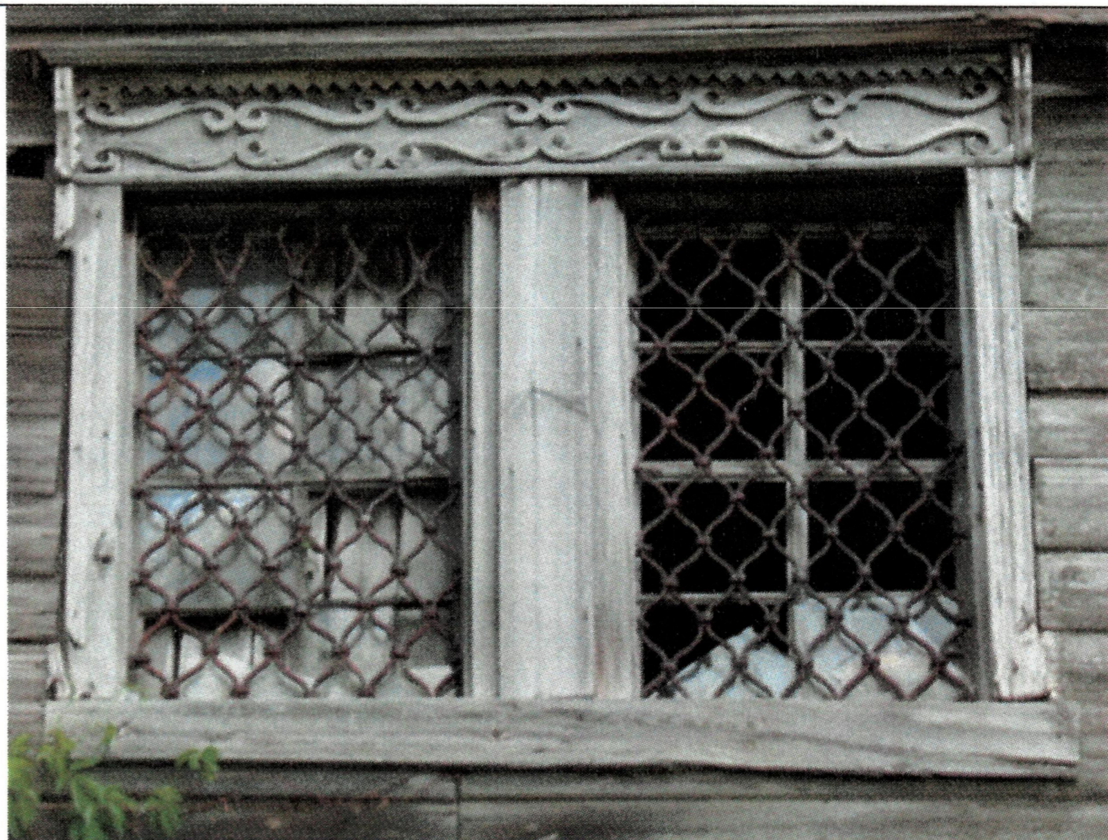
Рис. 26. Профилированные наличники с ушками, объединенные в верхней части сандриком (доской) с резным декором, завершающимся по флангам фигурными элементами с профилированной полочкой над ними в обрамлении сдвоенных окон второго света храмовой части северного и южного фасадов
