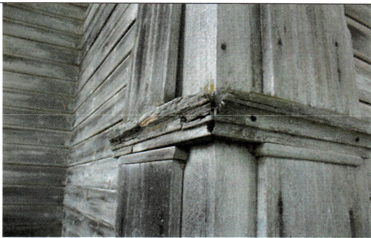
Рис. 27-28. Лопатки, стилизованные под пилястры с каннелюрами в центральной части, с полочками в нижней и верхней частях, акцентирующие углы фасадов
