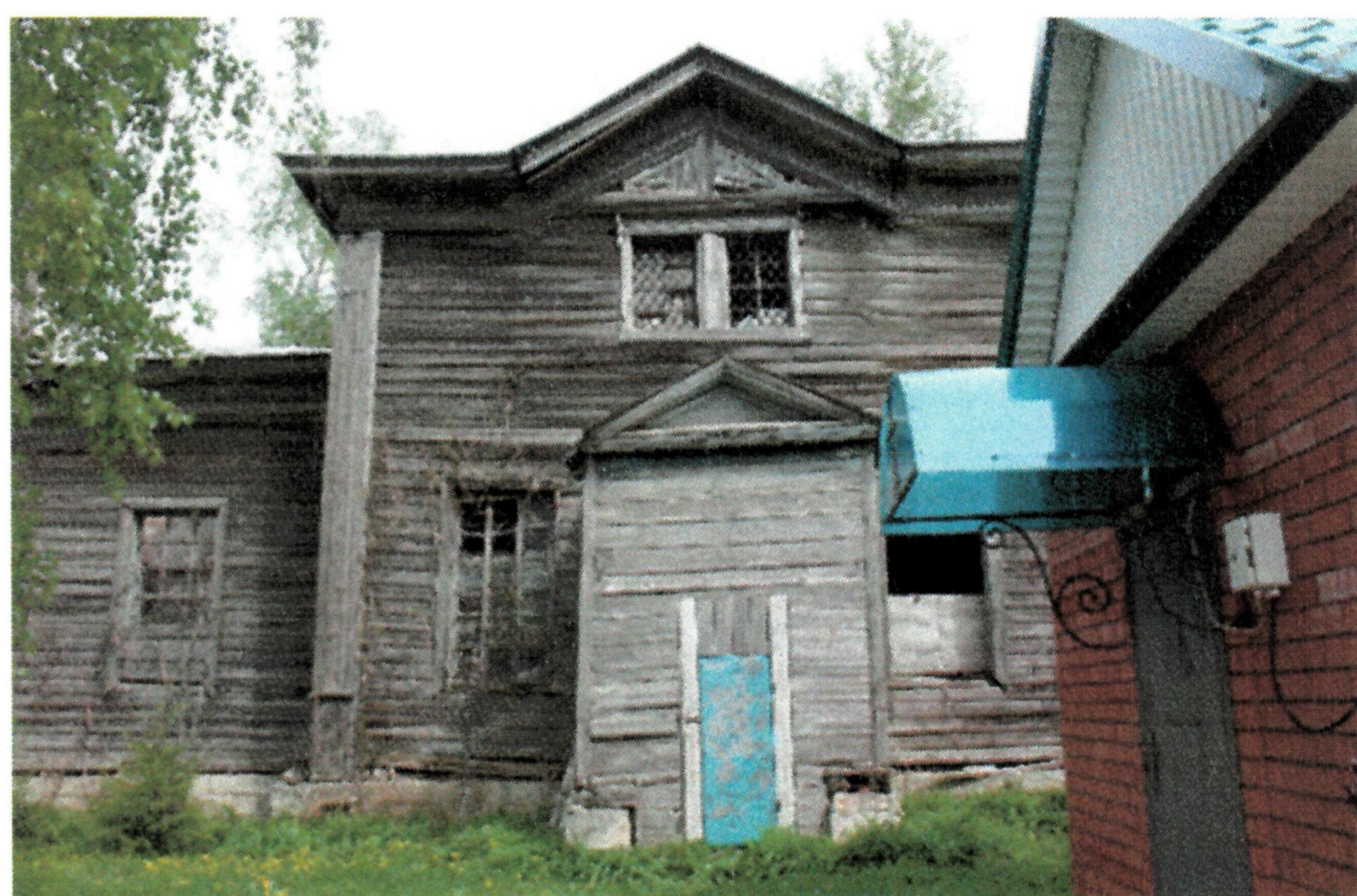
Рис. 11. Цоколь, выложенный из тесанных крупных блоков природного камня. Фрагмент южного фасада
