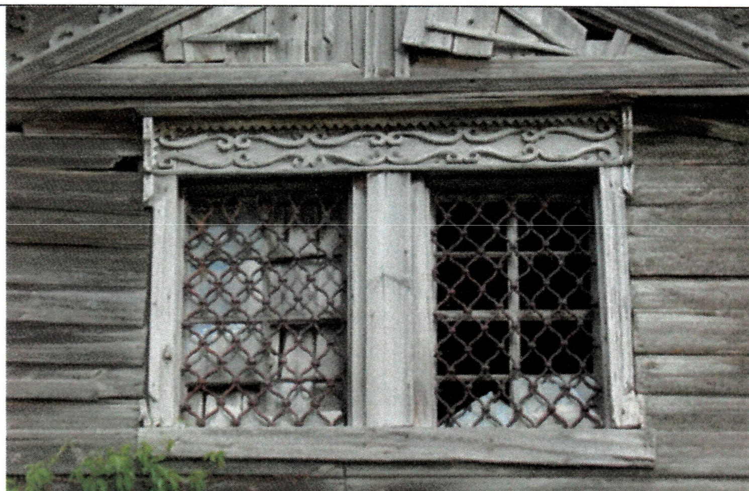
Рис. 58. Столярное заполнение оконных проемов второго света храмовой части с металлическими декоративными решетками
