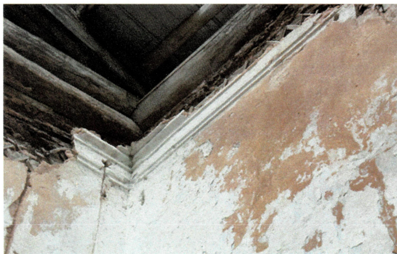
Рис. 46-49. Стесанные срубные бревенчатые стены и потолки, оштукатуренные по дранке под покраску в первом ярусе колокольни – притворе, трапезной, храмовой части и апсиде
