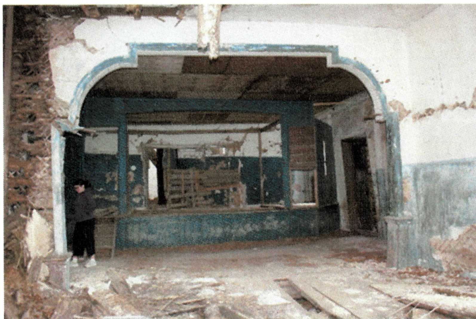
Рис. 44. Местоположение, геометрия, габариты и оформление арочного проема криволинейной формы между трапезной и храмовой частью
