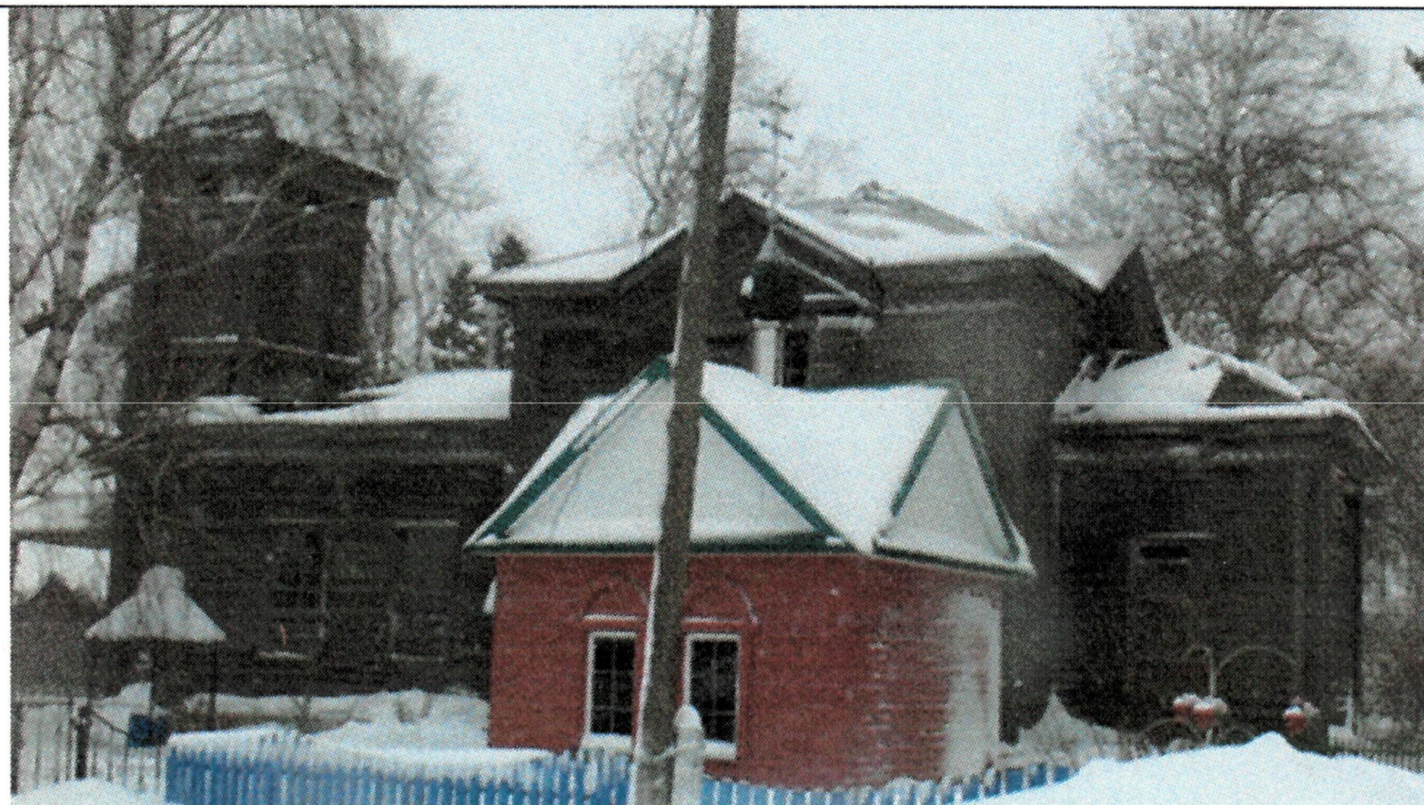
Рис. 16. Четырёхскатная крыша храмовой части с симметрично расположенными треугольными щипцами по осям на четыре стороны; с завершением главкой на восьмигранном барабане и крестом на яблоке (утрачены)
