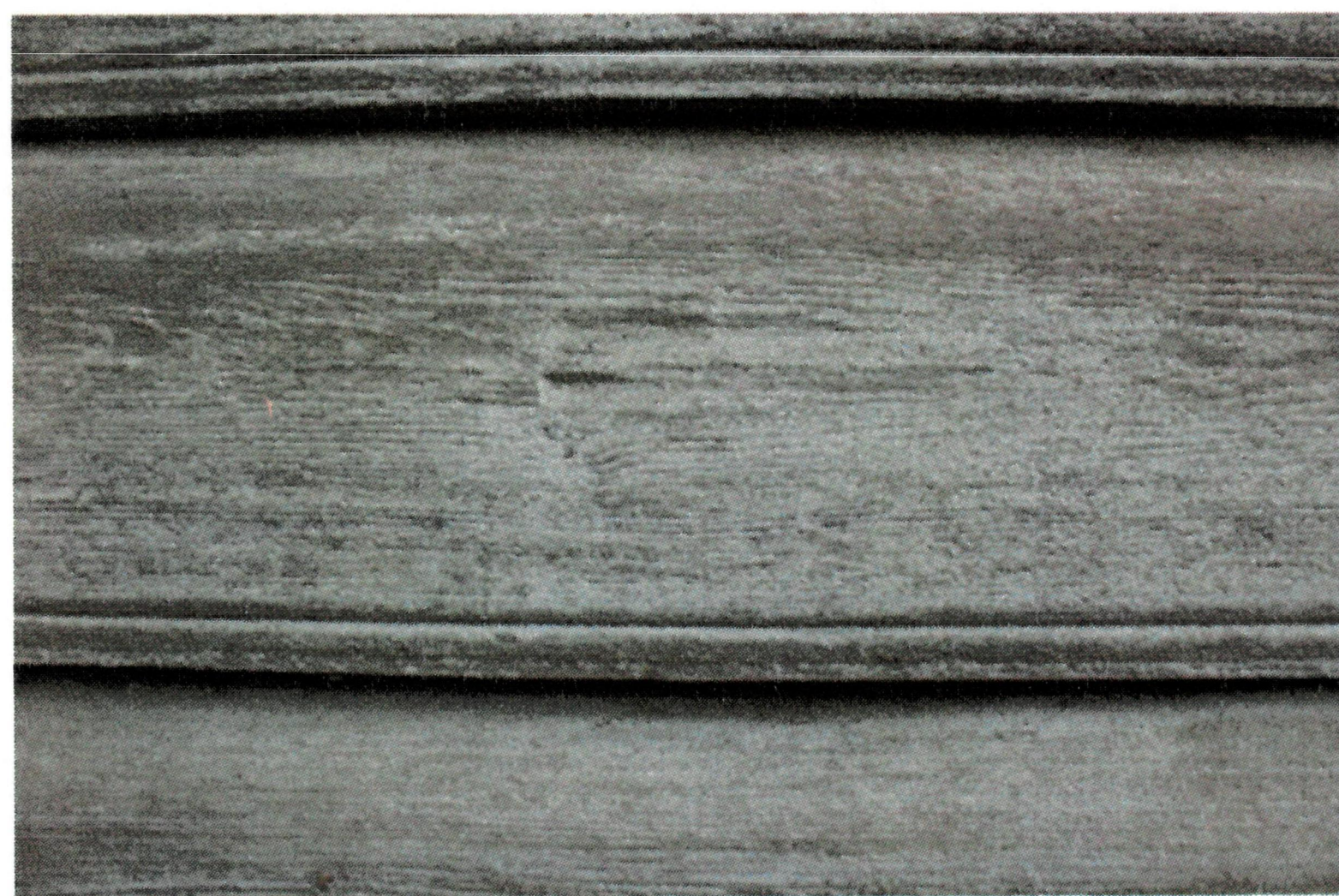
Рис. 22-23. Обшивочный профилированный тес в отделке фасадов
