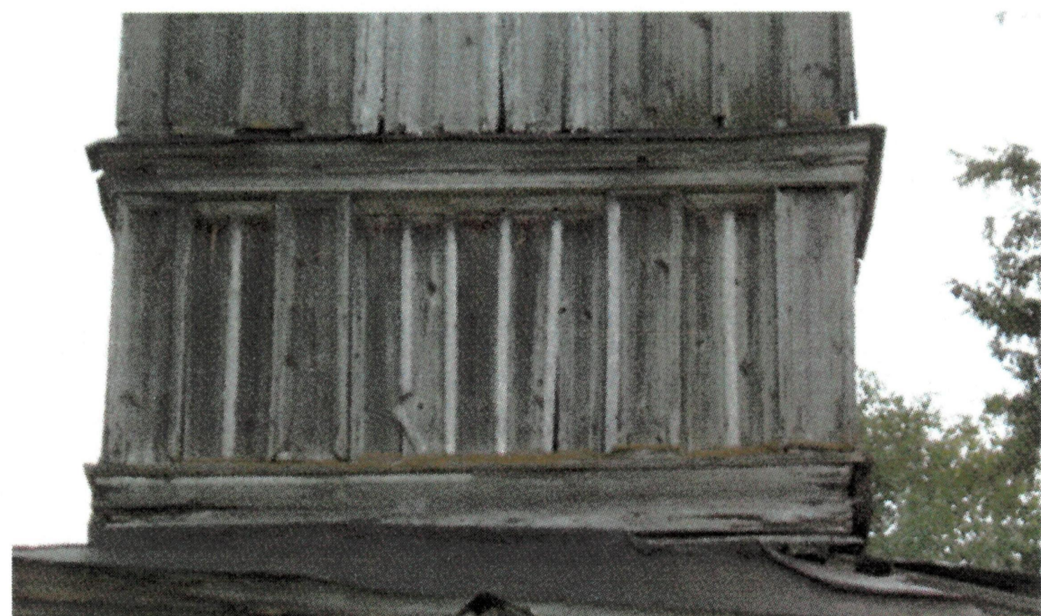
Рис. 34-36. Ниши в обрамлении тонких наличников простого профиля, в чередовании с аналогичными нишами, в центральной части которых расположены вертикальные профилированные рейки - в нижней и верхней частях второго яруса колокольни
