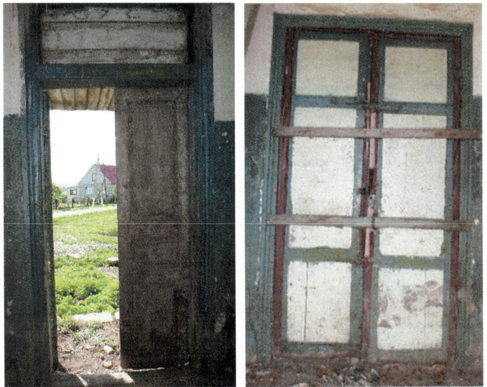
Рис. 62-63. Филенчатые столярное заполнение дверных проемов притвора (первый ярус колокольни), трапезной
