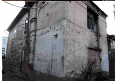
Рис. 28 - 31. Местоположение оконных проемов
