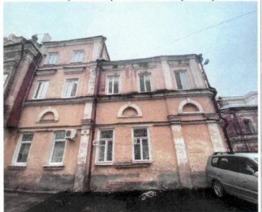
Рис. 22. Оконные проемы северного фасада
