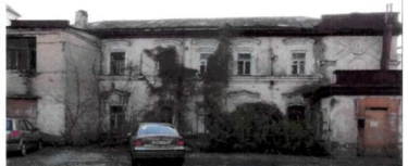
Рис 35. Местоположение дверных проемов
