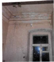
Рис. 8-9. Перекрытия второго этажа
