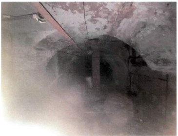
Рис. 7 - 9. Перекрытия подвального этажа
