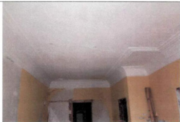
Рис. 13. Перекрытия второго этажа
