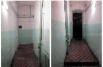
Рис. 10 - 11. Перекрытия первого этажа
