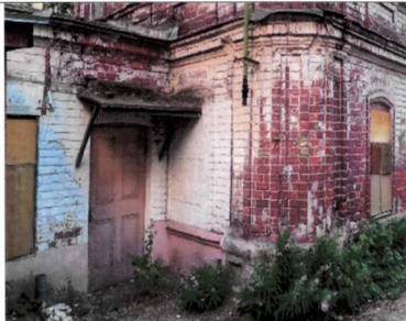
Рис. 16. Северный фасад восточного пристроя
