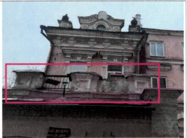
Рис. 21. Парапет второго этажа северного фасада
