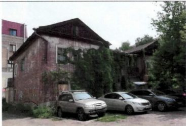
Рис. 16. Северный и западный фасады
