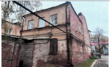
Рис. 27. Оконные проемы правого крыла западного фасада
