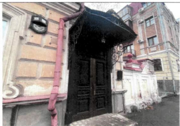
Рис. 36. Дверной проем восточного фасада
