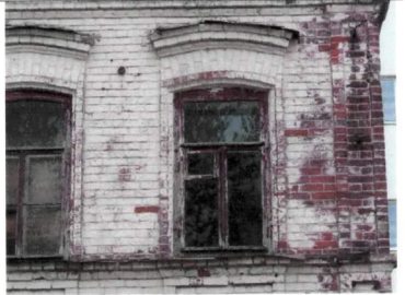
Рис. 7. Кирпичные перемычки оконных проемов
