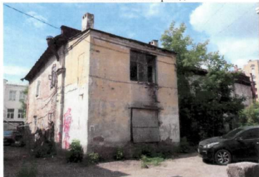
Рис. 5. Южный и восточный фасады
