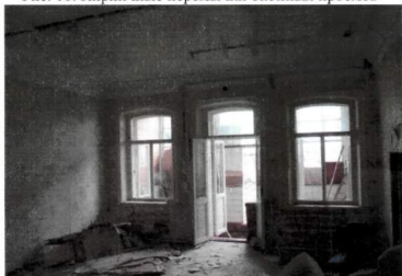
Рис. 11. Перекрытия первого этажа
