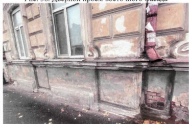
Рис. 37. Профилированный, филенчатый, раскрепованный цоколь восточного фасада
