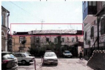
Рис. 14. Крыша здания с существующим расположением дымовых труб
