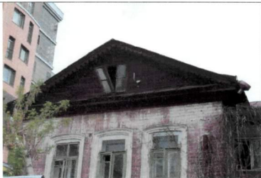
Рис. 10. Кирпичные перемычки оконных проемов
