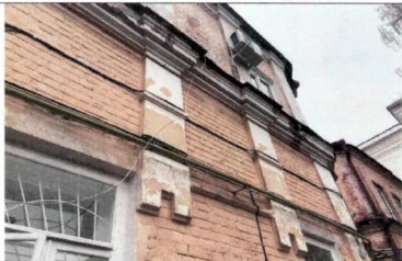
Рис. 24. Пилястры левого крыла западного фасада
