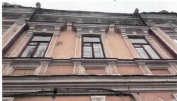
Рис. 34. Оконные проемы второго этажа восточного фасада
