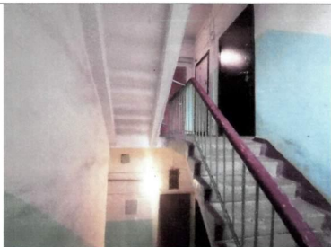
Рис. 12. Перекрытия второго этажа
