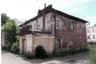
Рис. 17. Восточный и северный фасады
