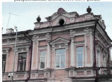
Рис. 38. Проемы второго этажа и аттик бокового ризалита восточного фасада
