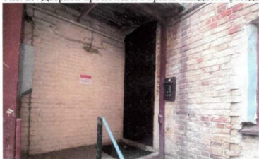
Рис. 26. Полуциркульный дверной проем западного фасада
