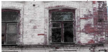
Рис. 30. Столярное заполнение оконных проемов
