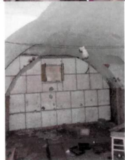
Рис. 11 - 12. Перкрытия подвального этажа
