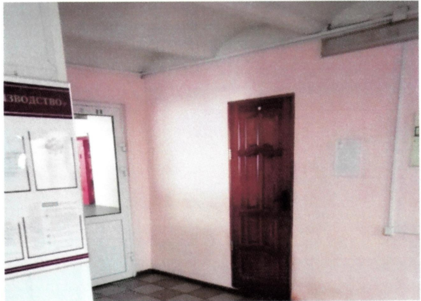
Рис. 7. Сводчатое перекрытие 1-го этажа
