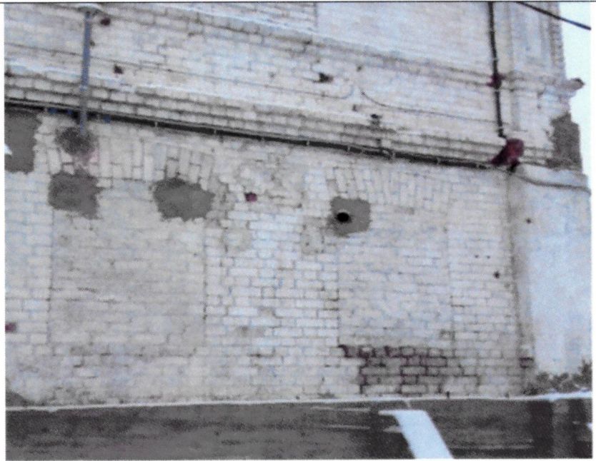
Рис. 9. Заложённые оконные проёмы с перемычками (боковой фасад)
