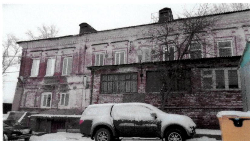
Рис. 19. Оформление оконных проемов 1-го и 2-го этажа
