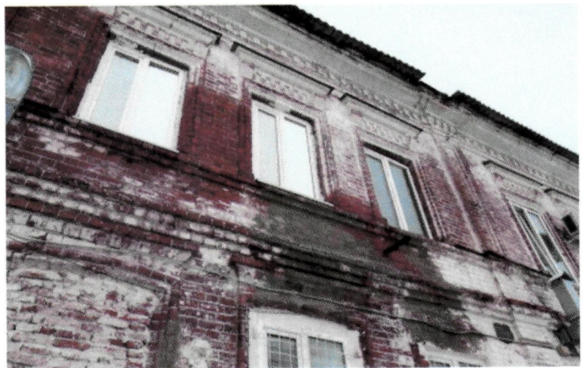
Рис. 8. Кирпичные перемычки (дворовой фасад)
