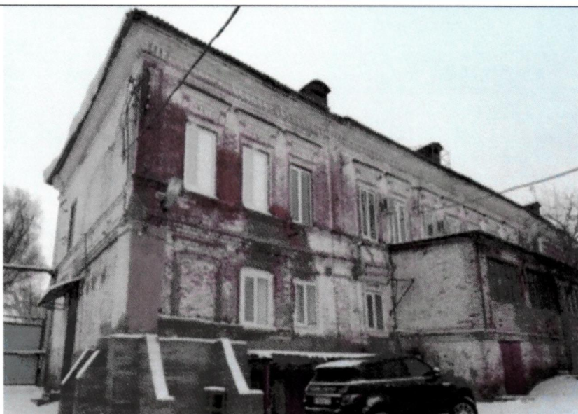
Рис. 18. Общий вид дворового (северного) фасада
