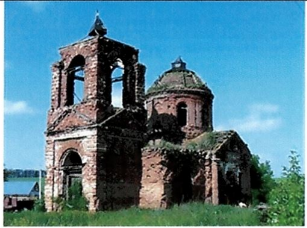
Вид на объект с юго-западной стороны с ул.Луговая
