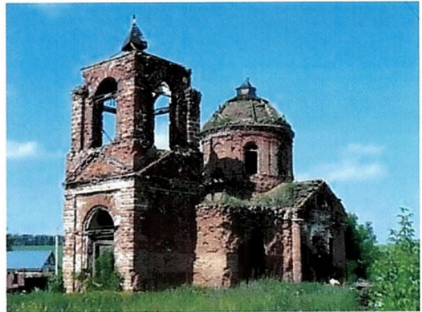
Арочные перемычки проемов колокольни и оконных проемов вторых ярусов храма и колокольни
