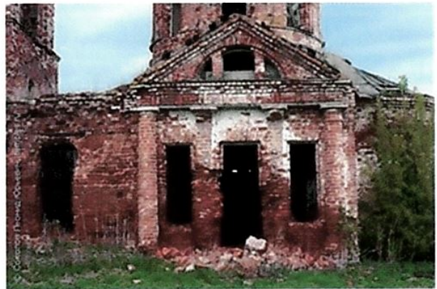
Клинчатые перемычки оконных и дверных проемов первого яруса храма со стороны фасада
