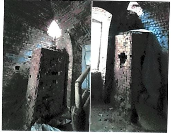
Две кирпичные прямоугольные в плане печи всеверной и южной частях трапезной
