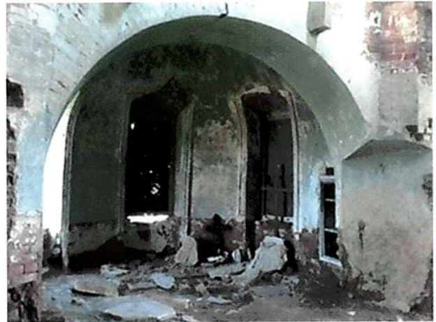
Профилированные тяги в обрамлении оконных и дверных проемов первого яруса апсиды
