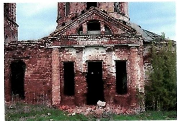
Первый ярус храма. Классический пристенный портик с четырьмя колоннами тосканского ордера, двумя высокими оконными и дверным по центру проемами. Портик завершается треугольным фронтоном с крупным полуарочным трехчастным проемом
