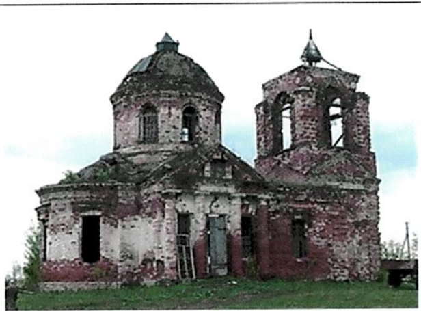
Общий вид на объект с северной стороны
