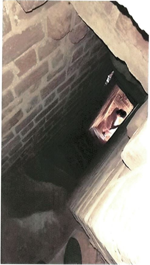
Каменная лестница на второй ярус колокольни в толще каменных стен
