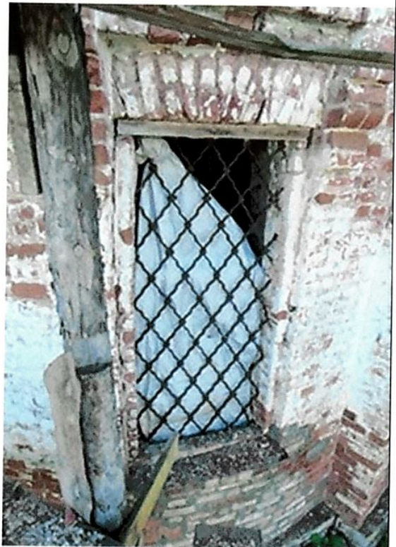
Кованые металлические решетки кубоватого рисунка оконных проемов первого этажа
