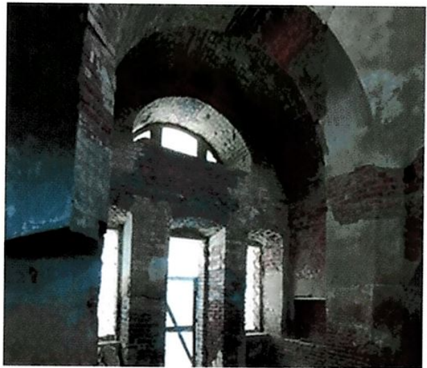
Цилиндрический свод кафоликона
