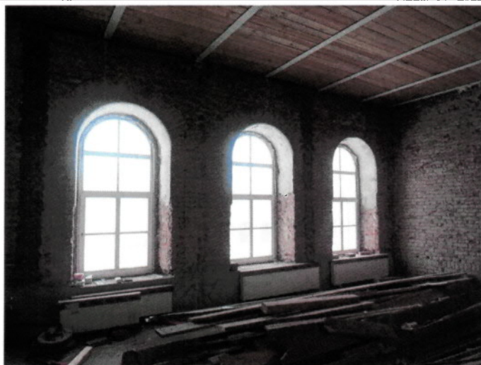
Силикатный кирпич по всей толщине стены
