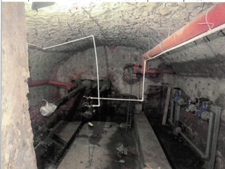
Кирпичные своды в подвале под центральным проездом
