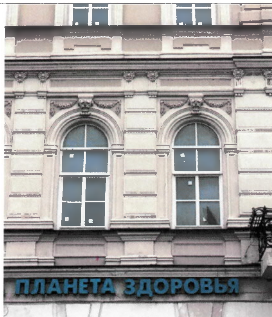
Оконные проемы 2 этажа
