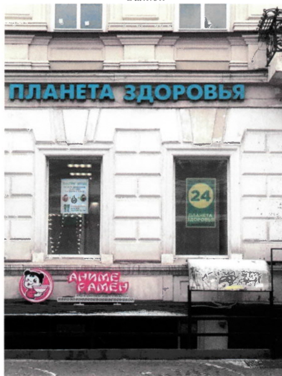
Оконные проемы 1 этажа
