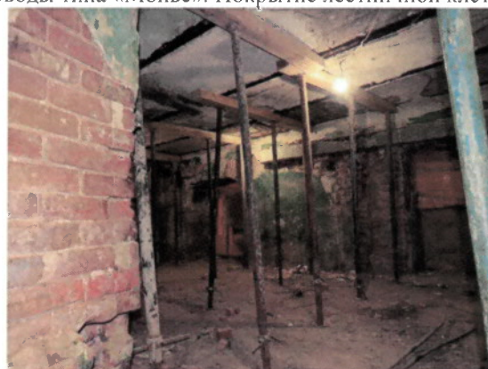
Своды типа «Монье». Подвальное перекрытие
