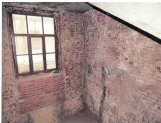
Силикатный кирпич по всей толщине стены
