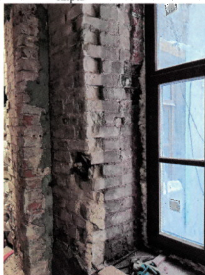
Кладка наружных стен. Комбинированная
