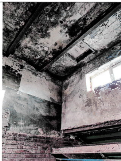
Своды типа «Монье». Покрытие лестничной клетки
