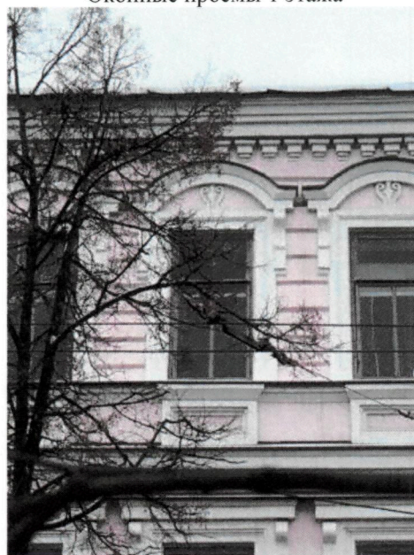
Оконные проемы 2 этажа
