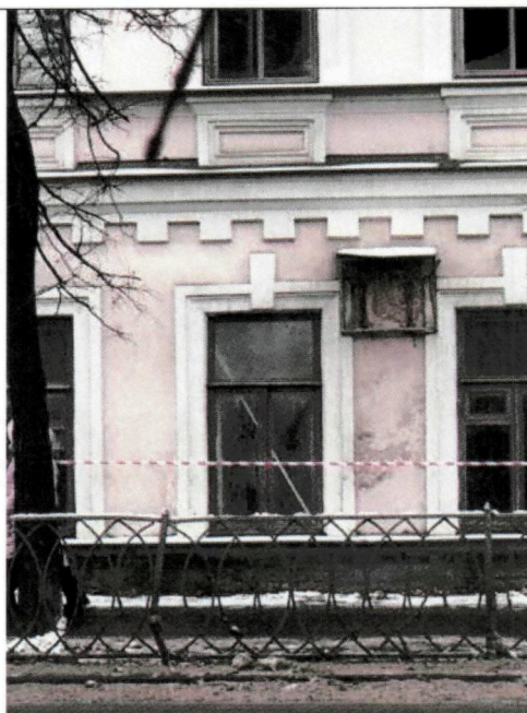
Оконные проемы 1 этажа
