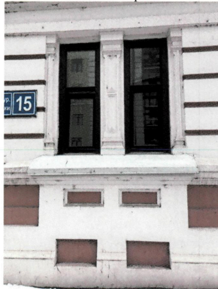
Оконные проемы 1 этажа
