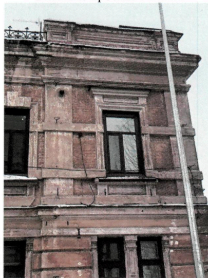
Оконный проем 2 этажа
