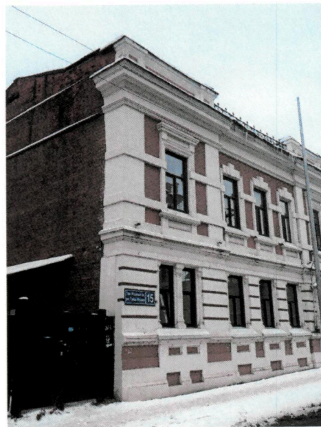
Фрагмент главного фасада
