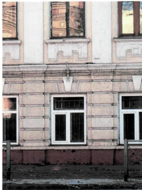
Оконные проемы 1 этажа
