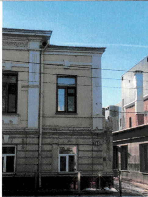
Боковой пристрой лестничной клетки
