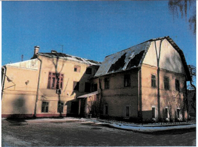
Общий вид со стороны двора
