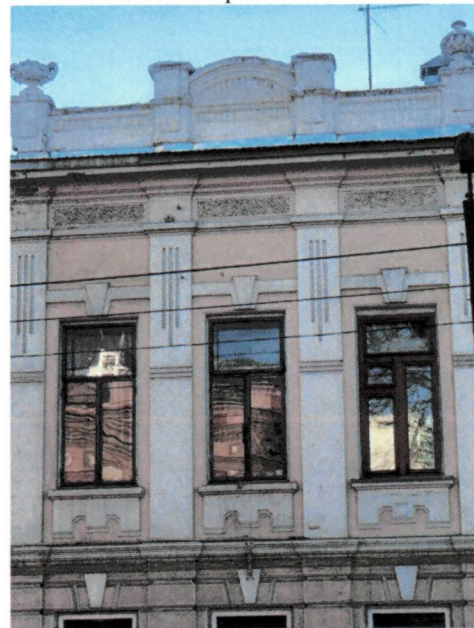
Оконные проемы 2 этажа
