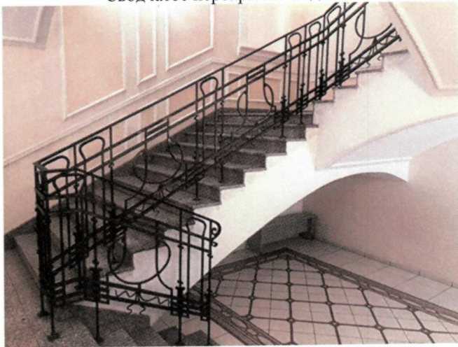
Центральная лестница по кирпичным сводам
