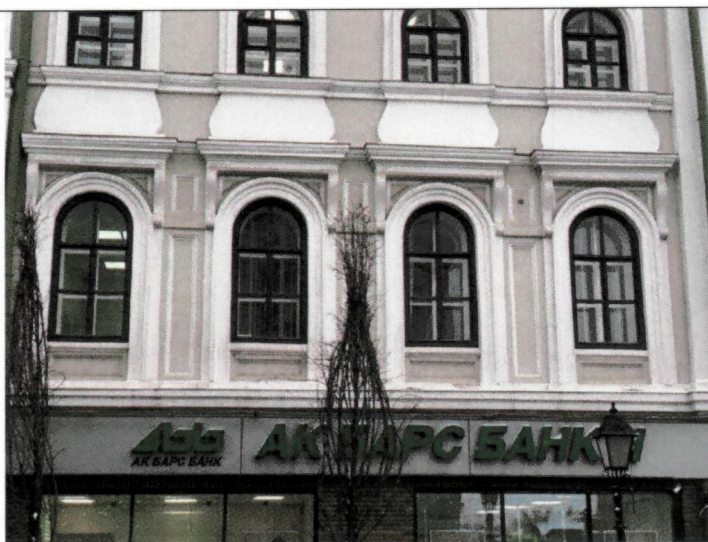
Оконные проемы 2 этажа
