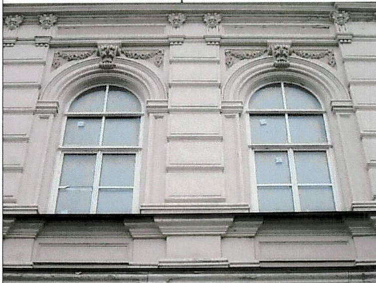
Оконные проемы 2 этажа
