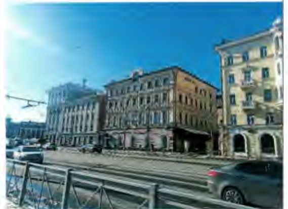
Общий вид на объект с улицы Пушкина
