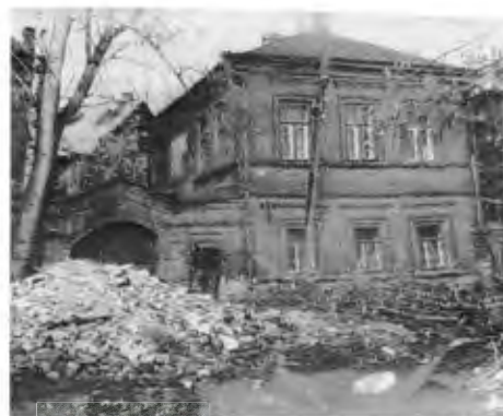
Общий вид главного фасада дома №12 со стороны ул. Михаила Худякова;
