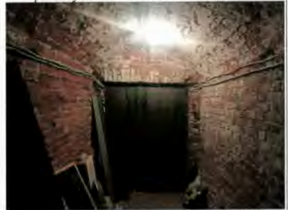
Кирпичные цилиндрический свод в помещении подвала
